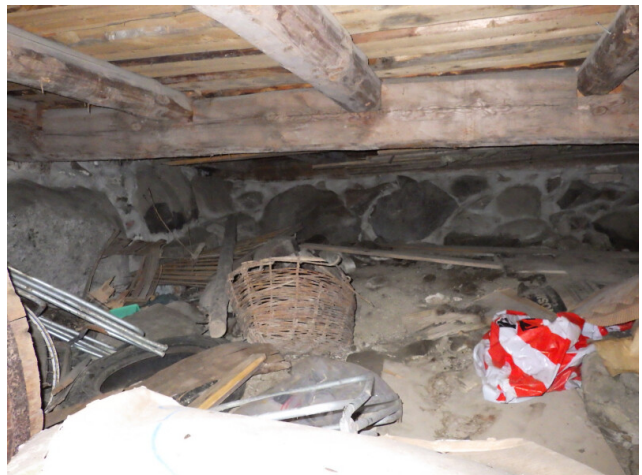
8. Ryömintätilaa ja alapohjaa
