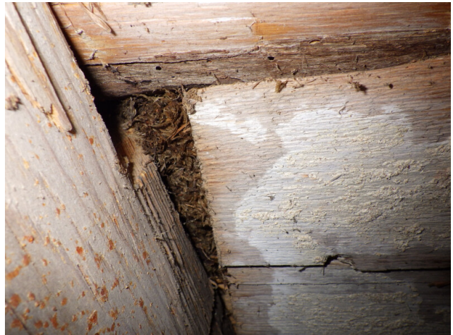
6. Alapohjarakennetta, palkin viereltä kuvattuna
