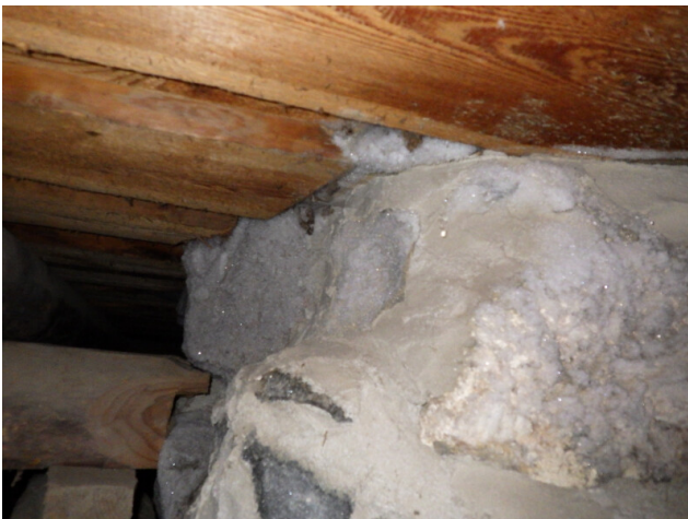
7. Alapohjaa ja tulisijan perustuksia. Perustuksien pinnalla "kuuraa".
