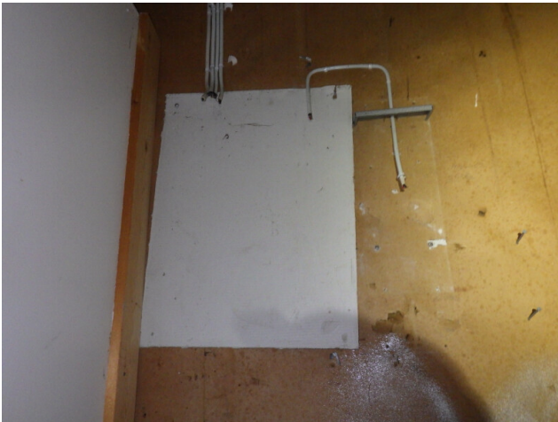
51. Sähköjohton päitä irrotetun ryhmäkeskuksen kohdalta
