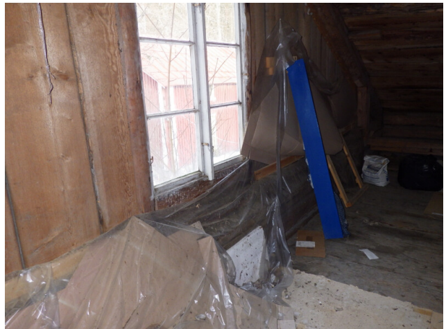
27. Seinustalle asennettu rakennusmuovi
