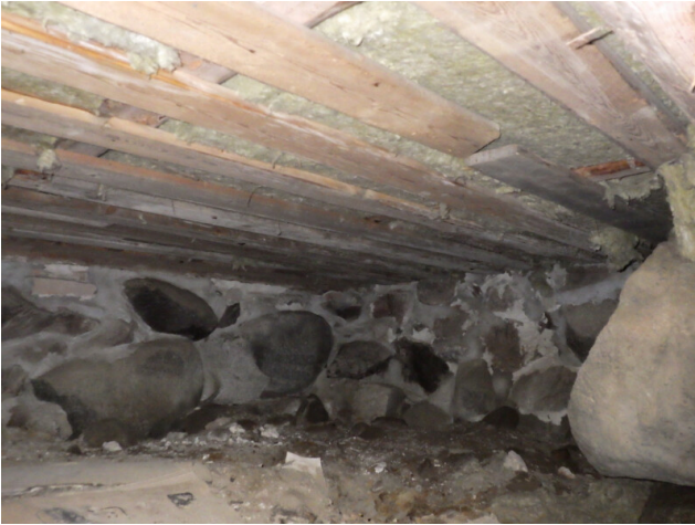
9. Ryömintätilaa ja alapohjaa. Alapohjan alapintaan asennettu mineraalivillaa.
