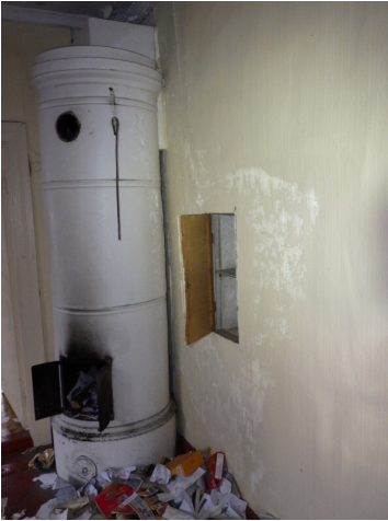
47. Sisätiloja ja tulisijaa. Tulisijan ja palomuurin pinnassa "kuuraa".
