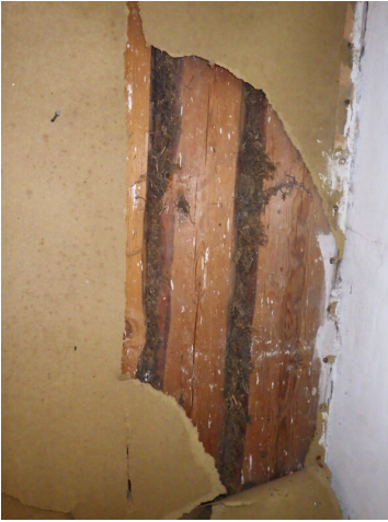
45. Hirsirakenteista väliseinää (pystyhirsi)
