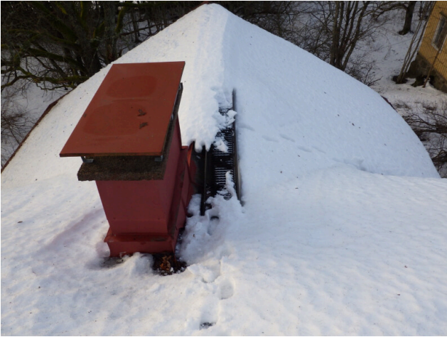
36. Vesikattoa ja savupiippua
