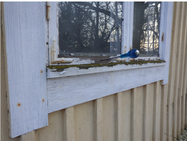
31. Lähikuvaa ikkunan alaosa
