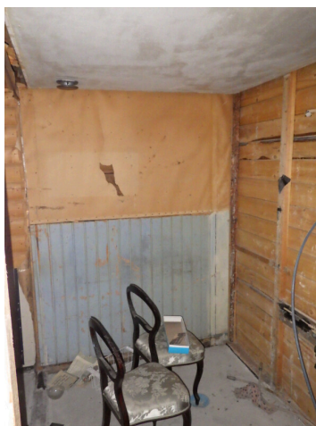
48. Kylmiötä/kylmähuonetta (rakenteita osin purettu)
