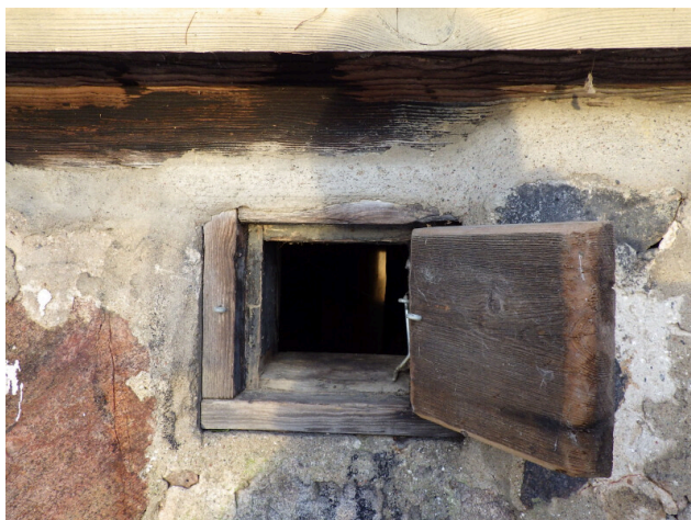
8. Ryömintätilan tuuletusaukkoa-/luukku
