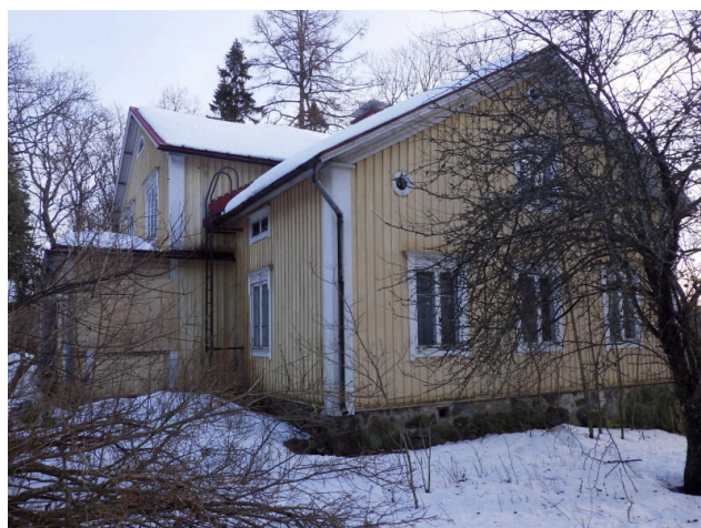
24. Julkisivua taka päädyistä
