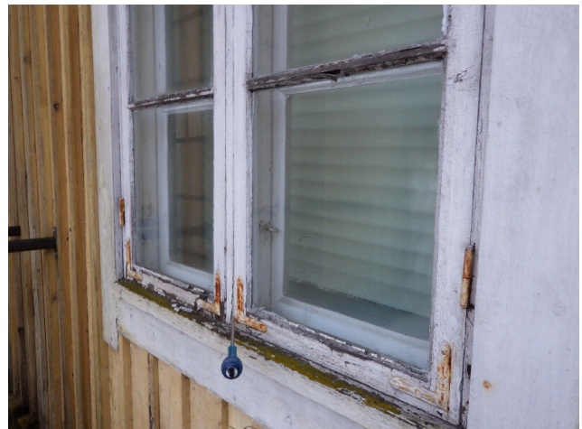
32. Lähikuvaa ikkunan alaosa
