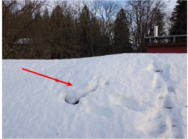
37. Yläpohjan kulkuluukku lumen ja jään alla
