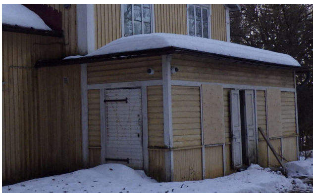
34. Kuistin pulpettikaton kaltevuus arvioitiin silmämääräisesti loivemmaksi kuin nykyisten ohjeistuksien mukainen vähimmäiskaltevuus 1:10
