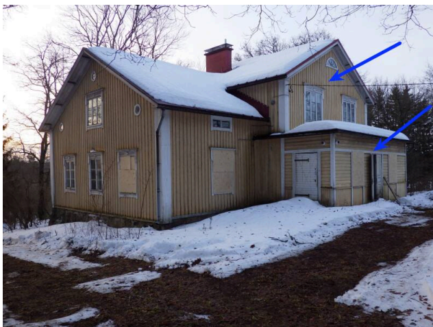
17. Julkisivua. Kuvassa näkyy laajennettu kuisti ja yläkerran laajennusosa (lisätty poikkipääty)
