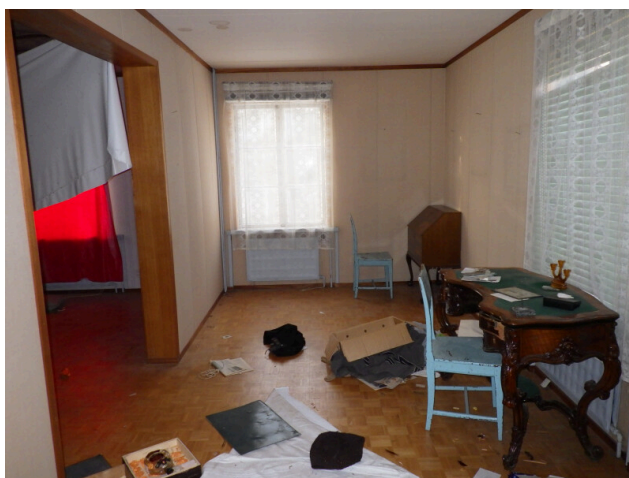
79. Sivu-ullakon alapuolisen huoneen katossa kosteusjälkiä, ks. seuraava kuva
