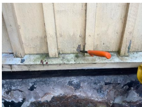
Ulkoverhouksen alaosassa esiintyy levää ja lahovaurioita.
