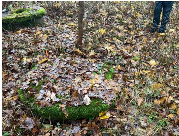
Rakennuksen lounaispuolella alarinteessä havaittiin vanhoja sakokaivoja, jotka purkavat vetensä rinteeseen alaosaan
