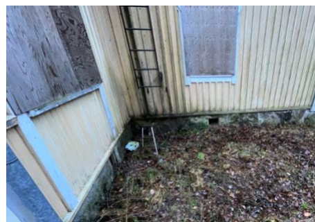
Ulkoverhouksen alaosassa esiintyy levää ja lahovaurioita.
