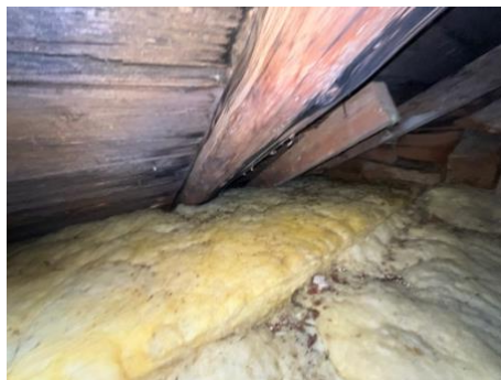
Yläpohjan tuulettuvassa tilassa havaittiin homeen hajua ja tuhoeläinten jälkiä. Tuuletus on tukittu laajasti mineraalivillalla.
