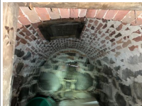
Osin tiiliholvattua kellaritilaa
