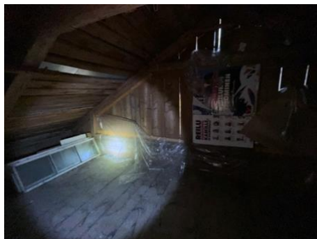
Ullakkotiloissa esiintyy laajasti vuotojälkiä ja kosteusvaurioita
