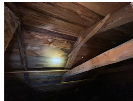
Ullakkotiloissa esiintyy laajasti vuotojälkiä ja kosteusvaurioita
