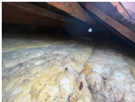
Yläpohjan tuulettuvassa tilassa havaittiin homeen hajua ja tuhoeläinten jälkiä. Tuuletus on tukittu laajasti mineraalivillalla.
