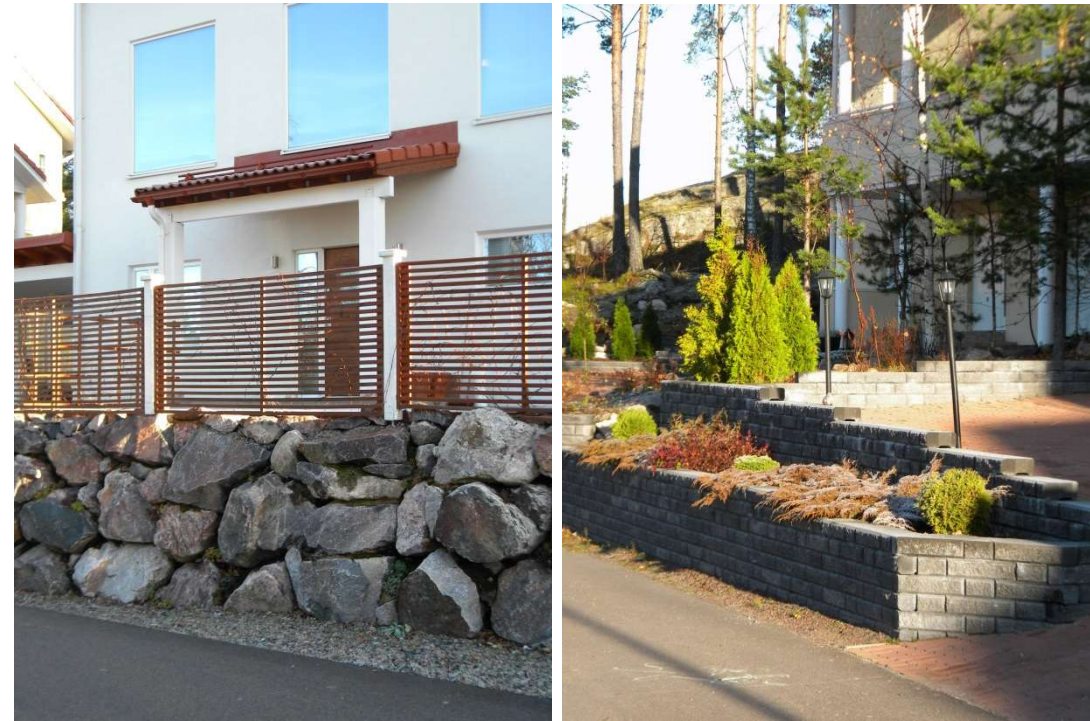
Kuva 7. Pihan ja kadun välinen korkeusero on ratkaistu kivimuurilla (kuva: Arja Sippola, Kirkkonummen Kolsarby).
