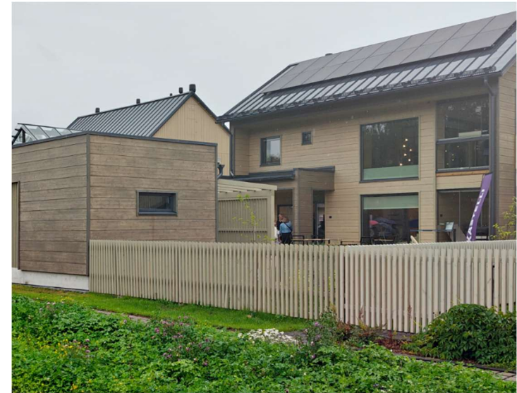
Kuva 9. Puinen rima-aita toistaa rakennuksen värisävyä (kuva: Mirjam Hyvönen, Hietasaari, Oulu).
