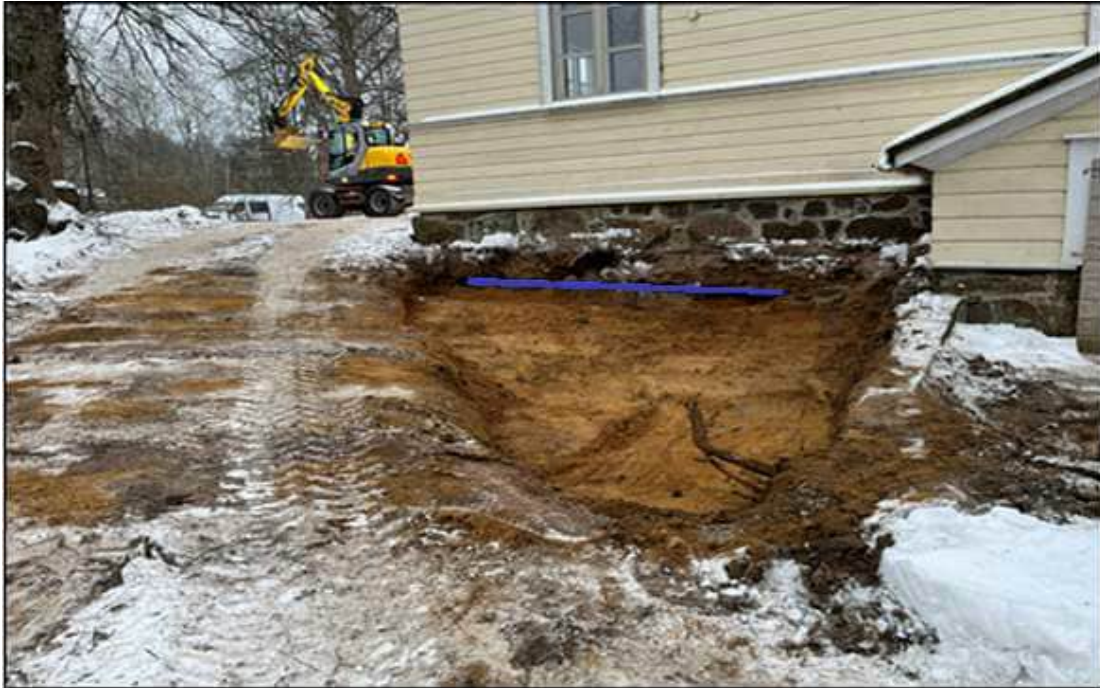
Kuva 8. Rakennuksen pohjoispuolen kaivualue 14.1.26. Lievästi pilaantunut maakerros jäi rakennuksen kivijalan alapuolelle, n. 0,4 m syvyydelle maanpinnasta (sininen viiva).
