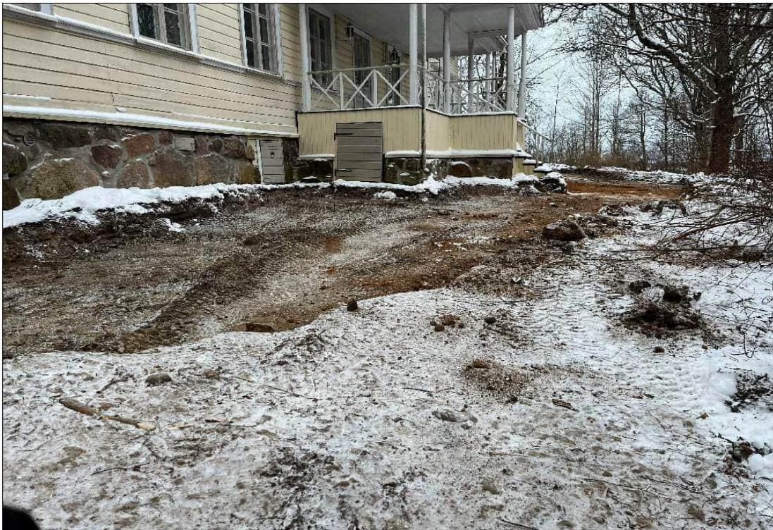
Kuva 4. Voimakkaasti ja lievästi pilaantunut pintamaa kaivettu ylös kartanorakennuksen etelä-länsipuolella 13.1.26, tutkimuspisteiden FCG7-FCG10 kohdalta.
