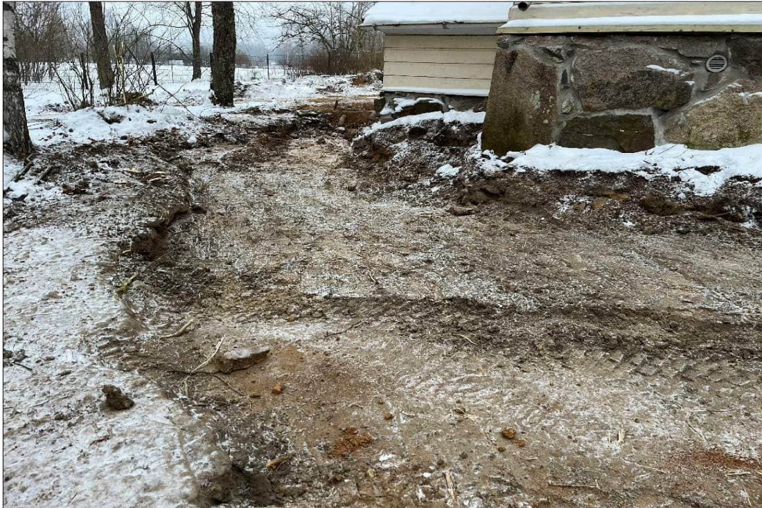
Kuva 5. Voimakkaasti pilaantunut pintamaa kaivettu ylös, kartanorakennuksen länsipuolella 13.1.26, tutkimuspiste FCG6-FCG7 kohdalta.
