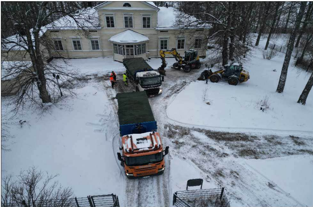
Kuva 14. Pilaantuneet maat kuljetettiin lavat peitettyinä Suomen Erityisjäte Oy:n 12.-21.26
