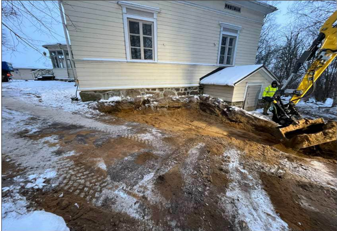
Kuva 7. Rakennuksen pohjoispuolen voimakkaasti pilaantuneen maan kaivualue 14.1.26.
