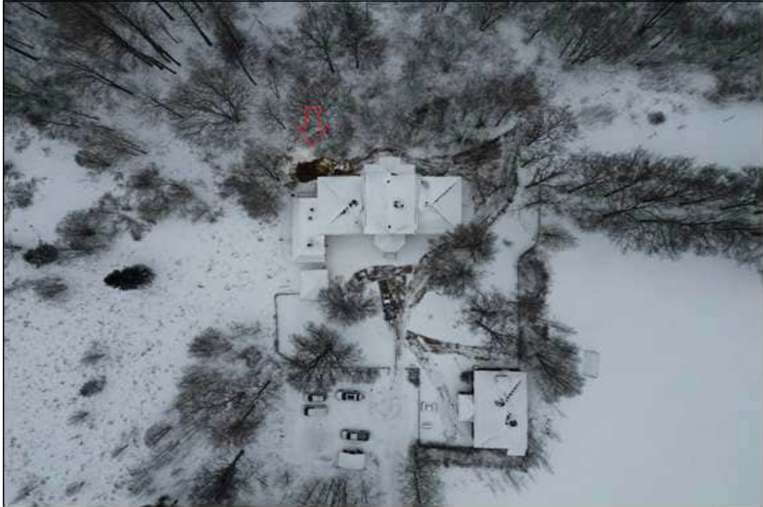
Kuva 1. Kartanorakennus 100 m korkeudesta kuvattuna. Maaperän kunnostustyön aloitus tutkimuspisteen FCG11 kohdalta, rakennuksen eteläpuolella 12.1.26 (pun. nuoli).
