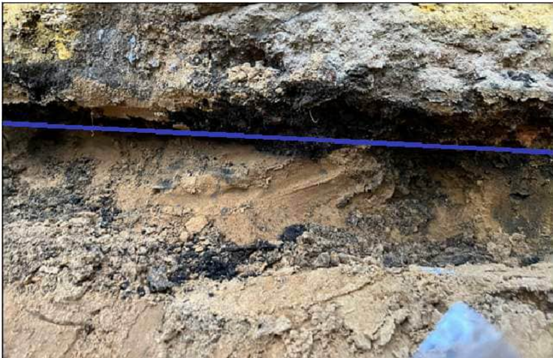
Kuva 9. Rakennuksen pohjoispuolella rakennuksen kivijalan alle n. 0,4 m syvyydellä maanpinnasta, jäi lievästi sinkillä pilaantunutta ohut kerros. Kuvassa erottuva ohut musta maa-aines (kuva 8 sinisen viivan alue). Suodatinkangas/eristerakenne asennettiin kivijalkaa vasten 26.1.26, erottamaan puhdas ja pilaantunut maa toisistaan.
