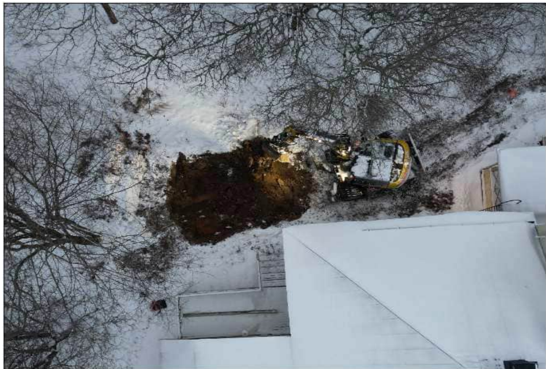
Kuva 2. Rakennuksen eteläpuoli tutkimuspisteen FCG11 kohdasta (kuva 1), kaivettiin ylös voimakkaasti pilaantunutta maata. Maan seassa todettiin 0,3-0,5 m syvyydeltä tiilijätettä.
