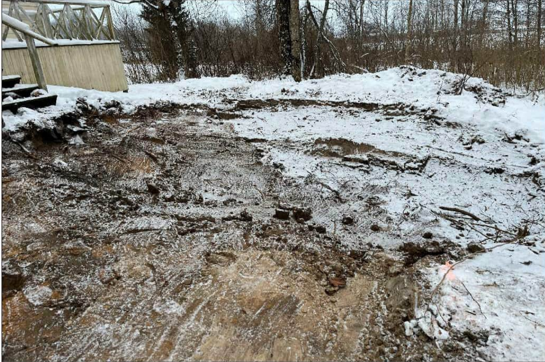
Kuva 3. Pilaantunut pintamaa kaivettu ylös, kartanorakennuksen eteläpuolella 12.1.26, tutkimuspisteen FCG11 kohdalta. Kaivualueelta poistettiin 0,3-0,5 m syvyydeltä tiilijäte.
