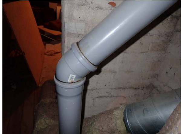
31. Viemärit ovat muovia.
