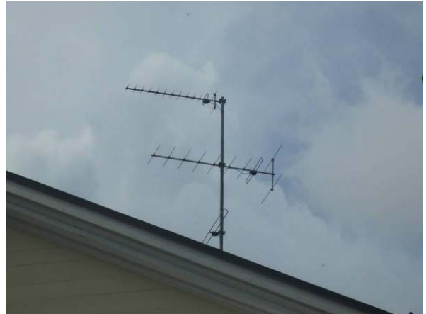
47. Harava-antenni rakennuksen katolla.
