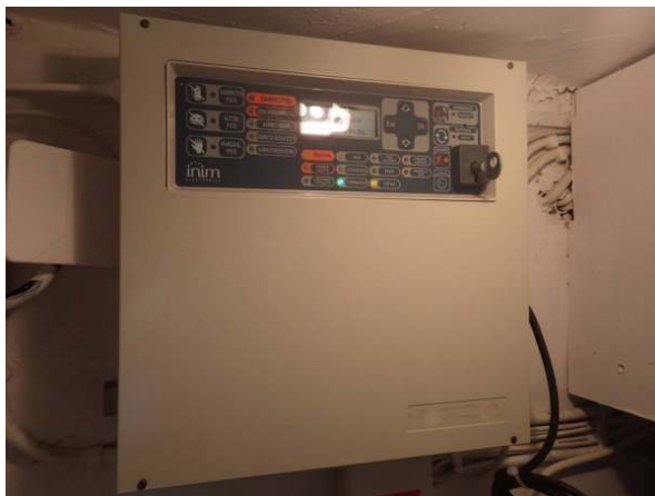
48. Paloilmoitusjärjestelmän ohjausyksikkö.
