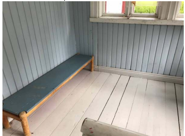
26. Lattia- ja seinärakenteita.
