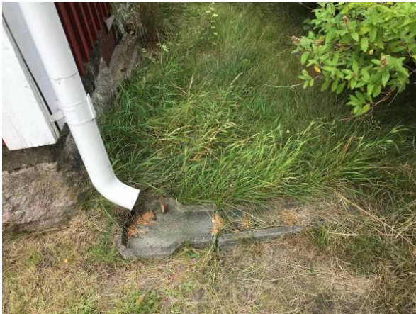
5. Katoilta tulevat vedet johdetaan syöksytorvista betonisilla pintakouruilla pois vierustoilta.
