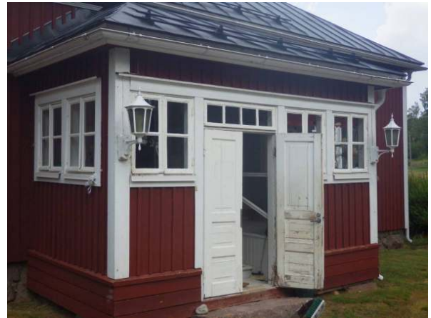
38. Rakenteisiin asennettuja valaisimia.
