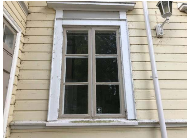
28. Puuikkunat ovat pääosin tyydyttävässä kunnossa.
