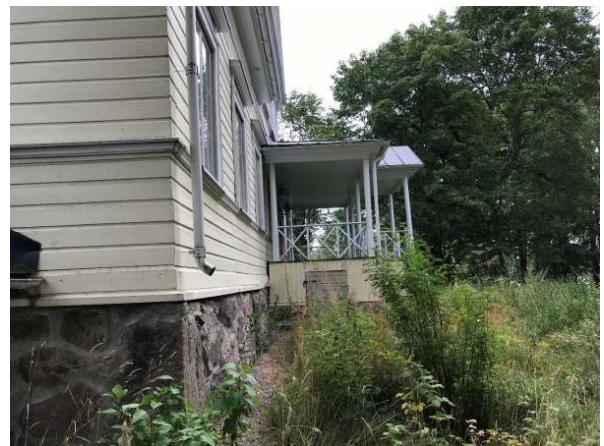
7. Syöksytorvi suositellaan jatkamaan ulottumaan betonikourulle.
