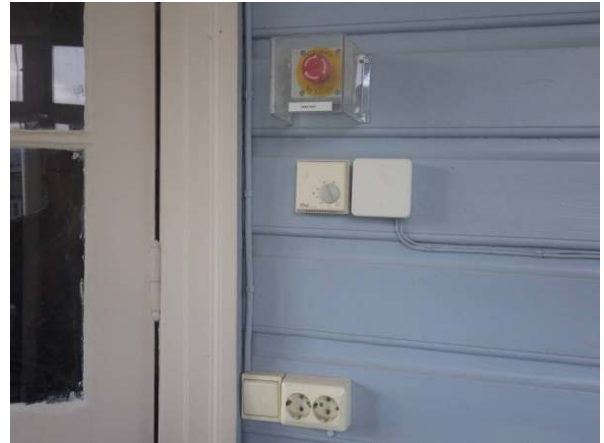
70. Säteilylämmittimien termostaatti.
