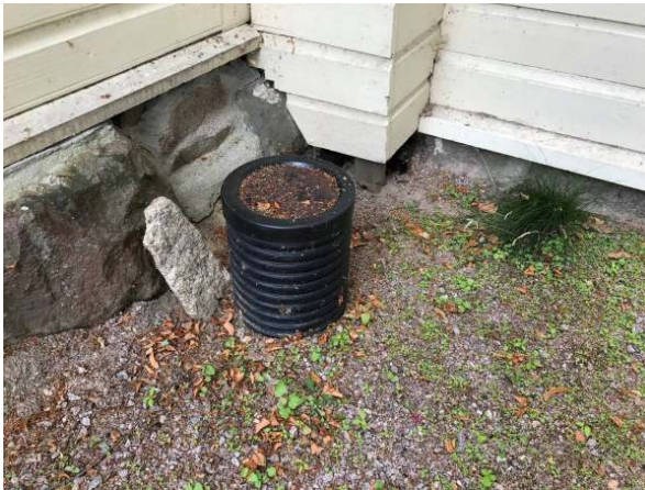
4. Etupihan salaojat asennettiin vuonna 2018.
