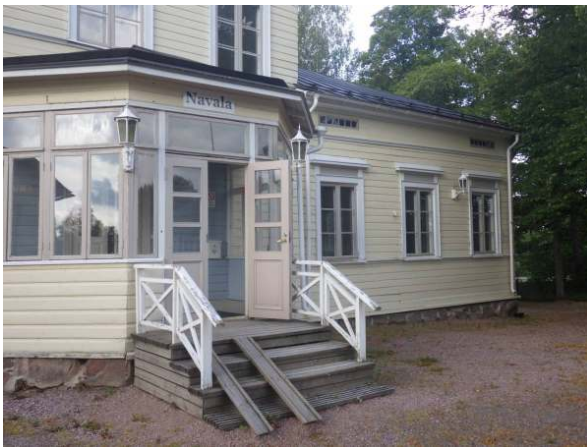
58. Rakenteisiin asennettuja valaisimia.
