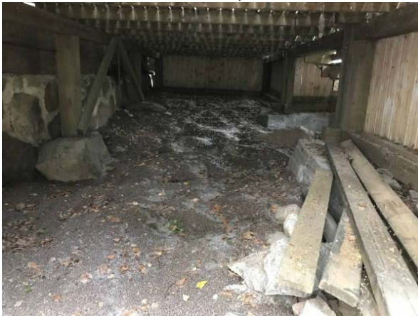
19. Terassin perustuksia on korjattu (mm. uusia betonianturoita on valettu)
