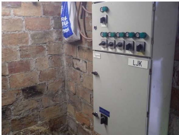
62. Lämmönjakuhuoneen keskus.
