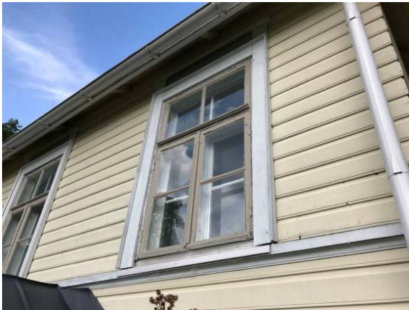
27. Puuikkunat ovat pääosin tyydyttävässä kunnossa.
