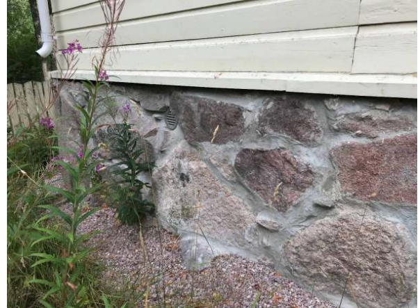
18. Sokkelirakenteita on korjattu.
