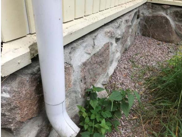
17. Sokkelirakenteita on korjattu.
