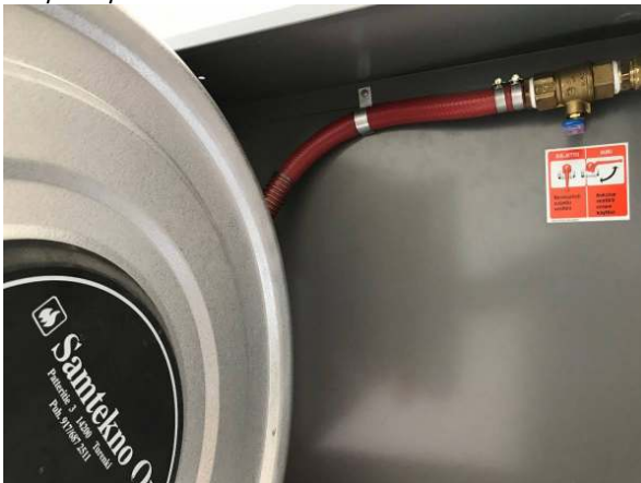
35. Pikapaloposteja ei ole tarkastettu.
