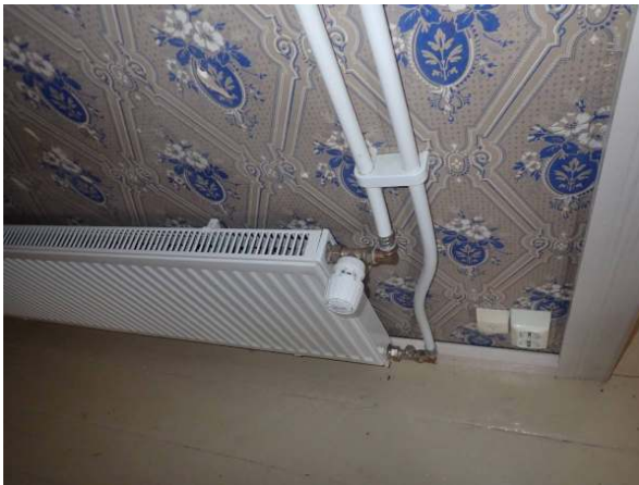
45. Termostaattinen patteriventtiili.
