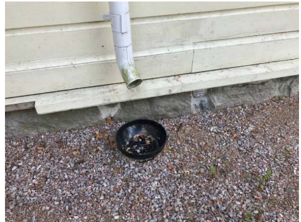
5. Etupihan sadevesijärjestelmä asennettiin vuonna 2018.
