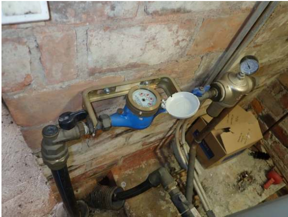
46. Kiinteistön päävesimittari.
