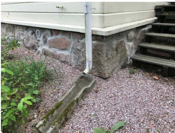
6. Takapihalla katoilta tulevat vedet johdetaan syöksytorvista betonisilla pintakouruilla pois vierustoilta.
