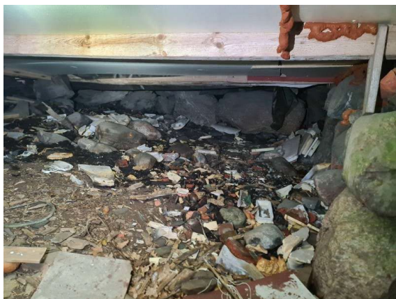
Bilder 17 och 18: Helmis stugas bottenbjälklag har förnyats med material innehållande plast. Övre bjälklaget har förnyats och isolerats med mineralull. (Källa: Byggnadens konditionsbesiktning 2021)
