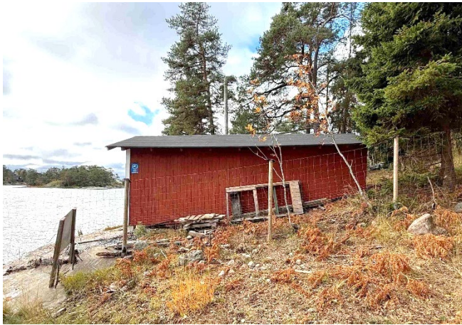
Kuvat 38 ja 39: Vasemmalla vanhempi pienempi venevaja pohjoisesta katsottuna, ja oikealla uudempi venevaja vastakkaisesta suunnasta, etelästä. Venevajat on perinteiseen tyyliin rakennettu "uppoamaan" rantatörmään; rakennustavan ja käyttötarkoituksen mukaan maapohja jatkuu vinona myös venevajan sisällä. (Valokuvat: P. Eriksson 2025)
