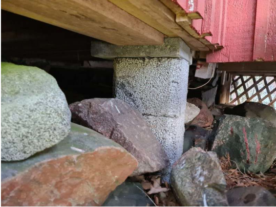
Kuvat 15 ja 16: Helmin tuvan perustuksia on korjattu ja muutettu. (Lähde: Rakennuksen kuntotarkastus 2021)
