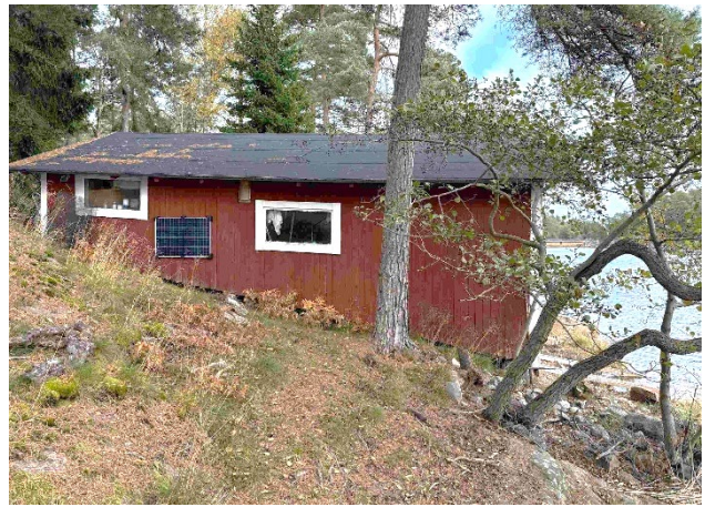
Kuvat 38 ja 39: Vasemmalla vanhempi pienempi venevaja pohjoisesta katsottuna, ja oikealla uudempi venevaja vastakkaisesta suunnasta, etelästä. Venevajat on perinteiseen tyyliin rakennettu "uppoamaan" rantatörmään; rakennustavan ja käyttötarkoituksen mukaan maapohja jatkuu vinona myös venevajan sisällä. (Valokuvat: P. Eriksson 2025)
