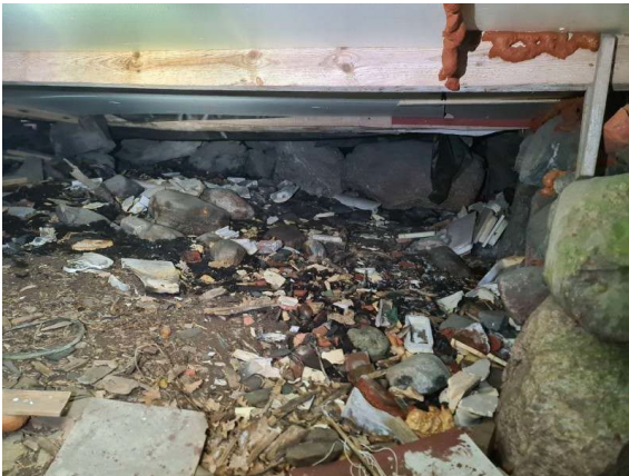
Kuvat 17 ja 18: Helmin tuvan alapohjaa on uusittu muovipitoisilla materiaaleilla. Yläpohjarakenteita on uusittu ja lämmöneristetty mineraalivillalla. (Lähde: Rakennuksen kuntotarkastus 2021)
