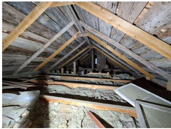
Kuvat 17 ja 18: Helmin tuvan alapohjaa on uusittu muovipitoisilla materiaaleilla. Yläpohjarakenteita on uusittu ja lämmöneristetty mineraalivillalla. (Lähde: Rakennuksen kuntotarkastus 2021)
