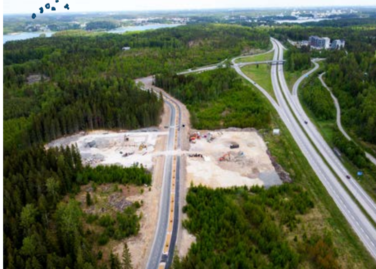
Datakeskuksen ja sen lähialueen rakentaminen on edennyt (kuva v. 2023).
