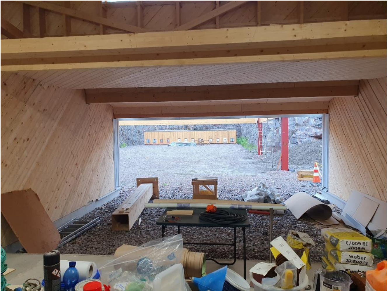
Kuva 3. Näkymä ampumakatoksesta radalle
