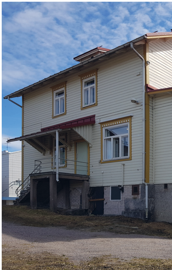
Kuva 16. Pohjoispäädyn sisäänkäynti Katoksen suojaamalle lastausovelle johtaa betoniraken- teinen portaikko.
