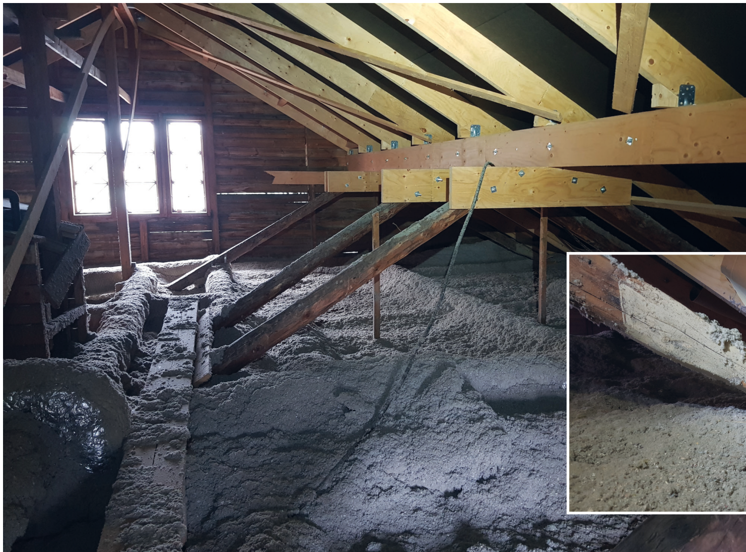
Kuva 123. Pohjoislaajennuksen vanhat kattotuolit
