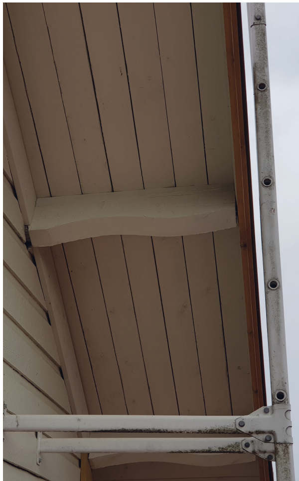
Kuva 22. Räystään kukkopuu
