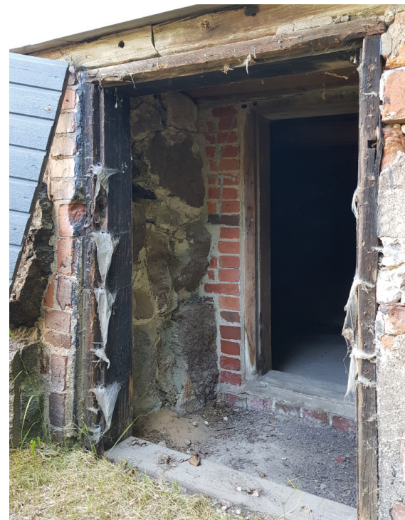
Kuva 107. Keskusosan länsijulkisivun sokkelia
