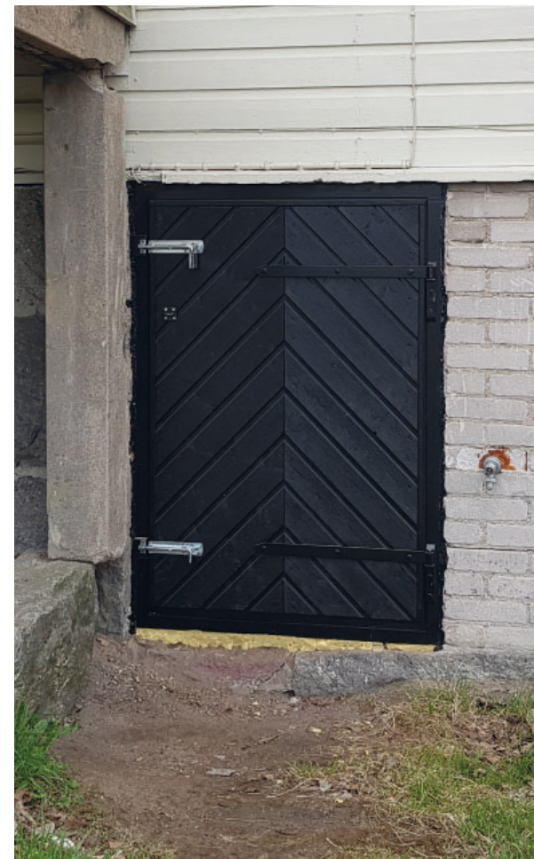
Kuva 56. Lämmönjakohuoneen uusi ovi Tuokokuussa 2023 uusitun oven saranat mukailevat saman seinustan vanhan oven tyyliä.
