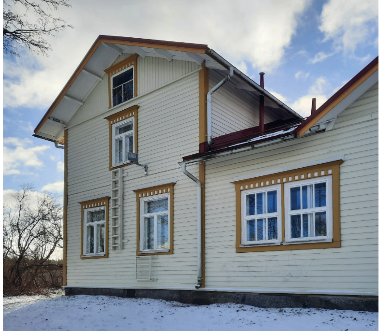
Kuva 52. Etelälaajennuksen ikkunajako Etelälaajennuksen ullakkoikkuna on ilmeisesti alkuperäinen. Kuva: Tuomo Könönen
