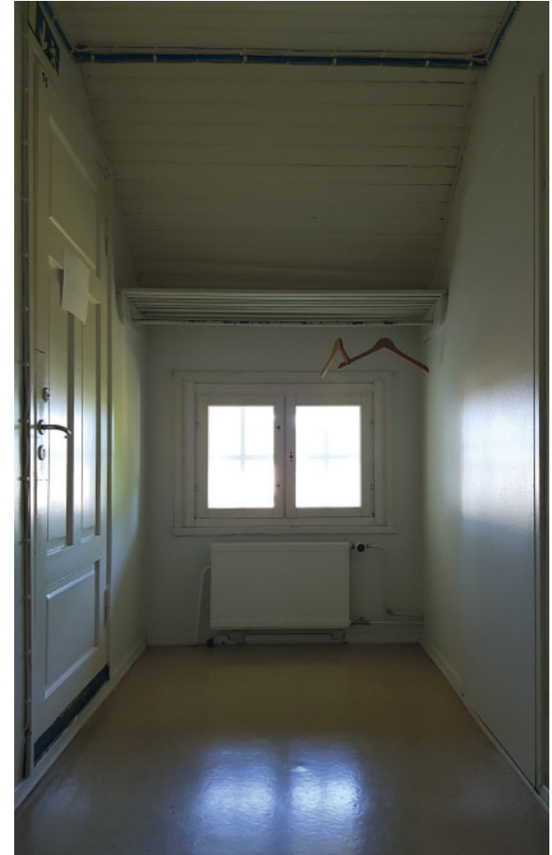
Kuva 51. Käytävätilan haukkaikkuna
