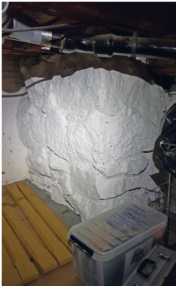
Kuva 115. Uunin perustus pohjoislaajennuksen kellarissa
