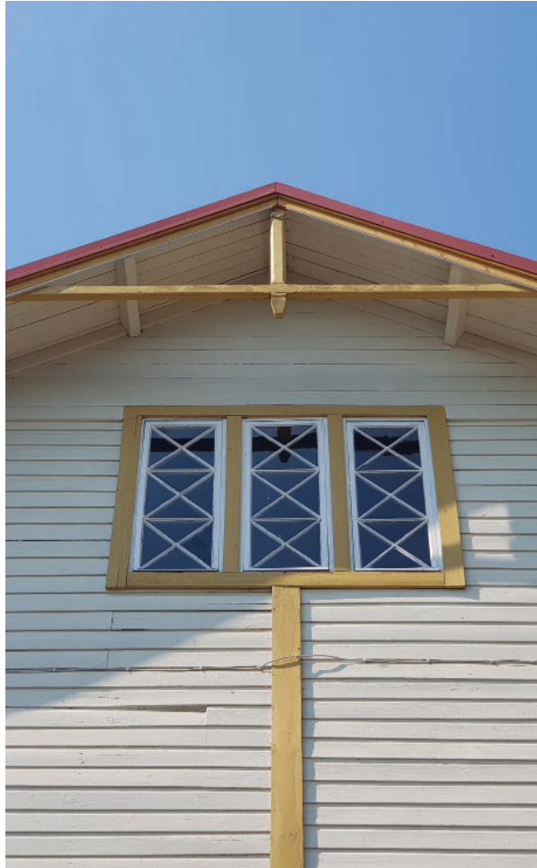
Kuva 50. Ullakkoikkuna ja ristipääty
