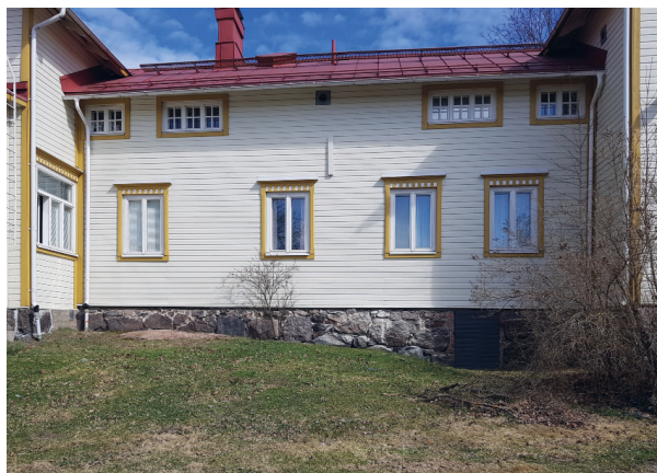
Kuva 110. Haukkaikkunat länsijulkisivulla Villa Hagan keskusosan toisen kerroksen ikkuna-aukotus on ensimmäisen kerroksen ikkunoista poiketen symmetrisen rakennusrungon suhteen.
