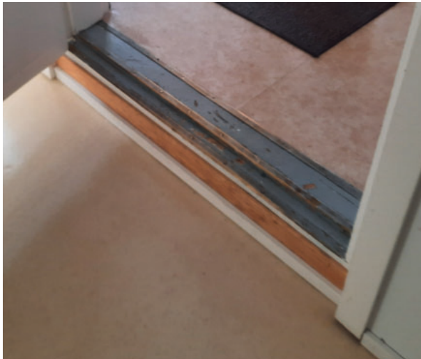
Kuva 91. Vanha kynnys uudessa oviaukossa
