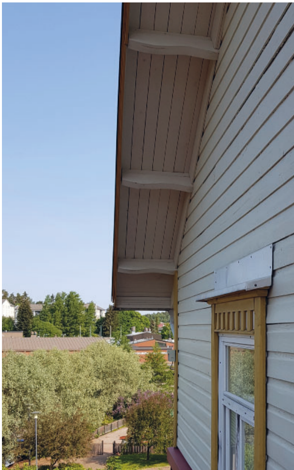
Kuva 43. Pohjoispäädyn räystäspannat
