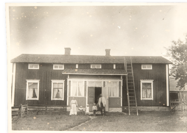
Kuva 111. Tavanomainen tuparakennuksen haukkaikkunajärjestys Närpiössä 1910-luvulla kuvattu Hermansin tilan päärakennus, ilmeisesti paritupa, jossa ullakon haukkaikkunat mukailevat ensimmäisen kerroksen ikkunajakoa.
