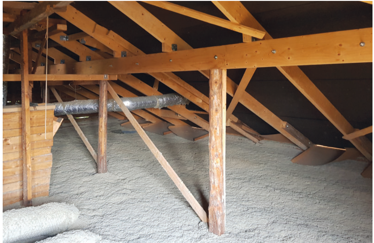
Kuva 92. Uusia kattorakenteita ja puhallusvillaa pohjoislaajennuksen ullakolla
