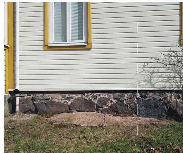
Kuva 102. Mahdollinen yksittäistuvan nurkkakivi Keskusosan länsijulkisivussa erottuu tummempi kivi, jonka pysty särmä asettuu täsmälleen ensimmäisen kerroksen väliseinän linjaan.
