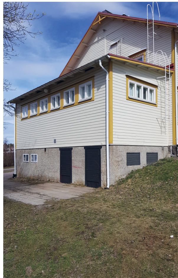
Kuva 17. Pohjoislaajennuksen lisäosa Pohjoislaajennuksen toisesta kerroksesta on poistumis- reitti lisäosan katolle ja edelleen sen etäläjulkisivulta tikkaita alas.
