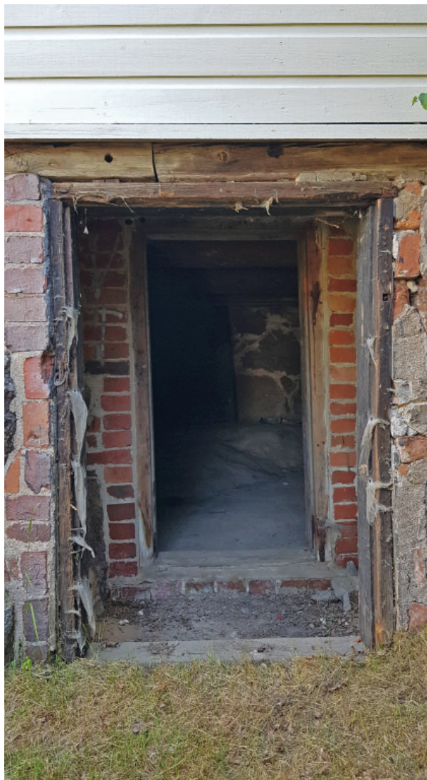
Kuva 35. Keskusosan kellarin sisäänkäynti
