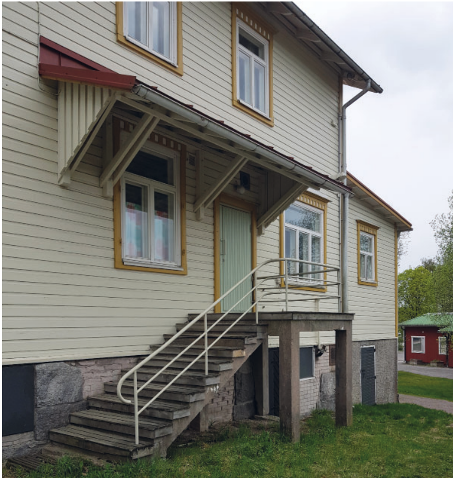
Kuva 47. Lastausovi ja katos, nykytilanne Pohjoispäädyn oven ja portaan päälle on rakennettu katos.
