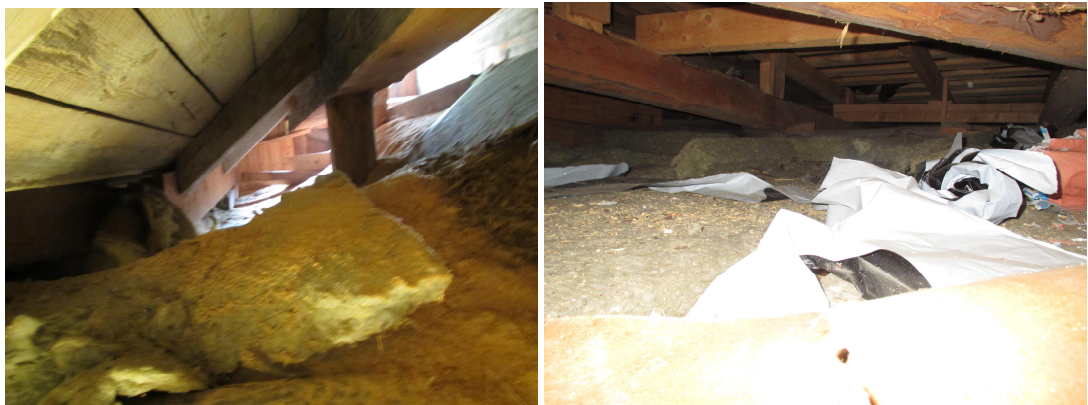
Kuvat 76 ja 77. Rakenneavaus RAK 7. Alemmalla tasolla oleva loivan katon osan yläpohjan lämmöneristeet on uusittu mineraalivillalla. Ullakkotilassa oli korjauksen yhteydessä jääneitä roskia, muovisäkkejä ja purua. Muuten ullakko oli varsin hyvässä kunnossa.
