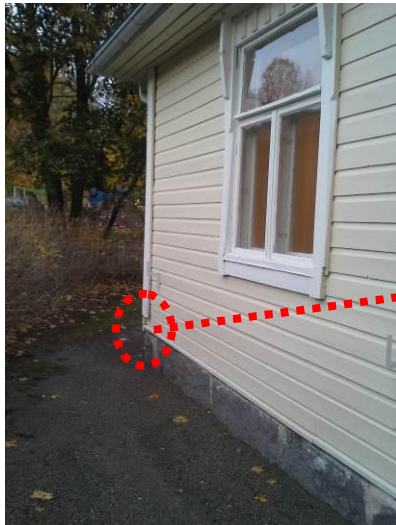
Kuvat 9 ja 10. Rakennuksen etelän puoleisessa kulmassa havaittiin julkisivulaudoituksen takana lahonnutta puurakennetta. Kyseisessä kohdassa julkisivuverhouksen sauma oli auki, jonka kautta sadevesi on päässyt rakenteeseen. Oikean puolen kuvassa näkyy, että luonnonkivisokkelin päällä hirsirungon alapuolella on kermikaista.
