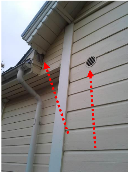
Kuva 23. Rakennuksen kaakkoispuolella on ullakolle menevät tuuletussäleiköt.
