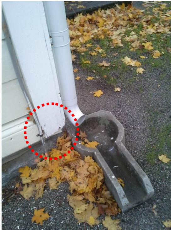
Kuvat 20 ja 21. Pääsisäänkäynnin erkkerin nurkkalaudoitusten alaosan puut ovat lahovaurioituneet. Vaurioituneet kohdat on ylimaalattu.
