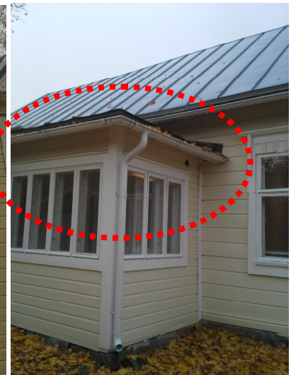
Kuvat 72 ja 73. Vasemmassa kuvassa loiva katon osan vesikate on uusittu ja alle on asennettu aluskermi. Oikeassa kuvassa on pääsisäänkäynnin erkkerin katto, joka on selvästi loivempi kuin korkean osan katto.
