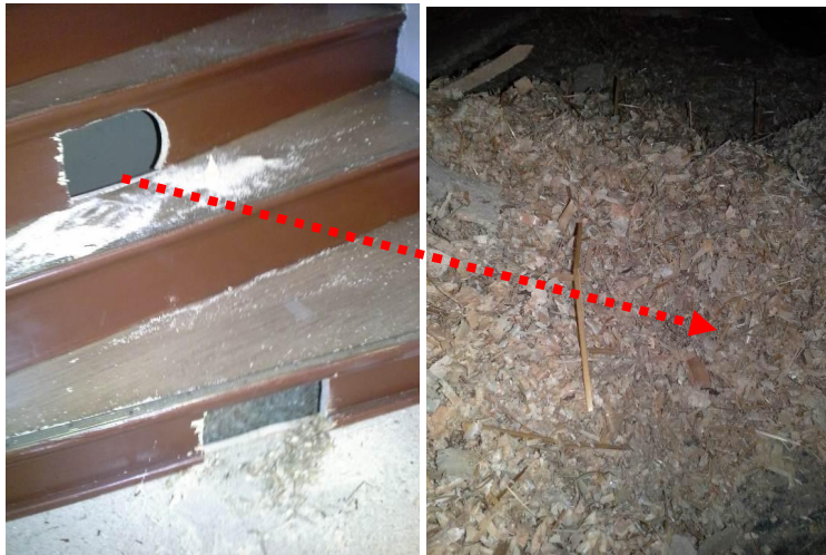
Kuvat 48 ja 49. Rakenneavaus RAK 3 portaikkoon. Avauksista nähdään, että portaikon alla on umpinainen tila, jonka pohjalla on alapohjan purukerros näkyvissä. Purun pintaosa oli siisti, mutta syvemmälle purukerrosta ei ulottunut tarkastamaan pienestä avausreiästä johtuen.
