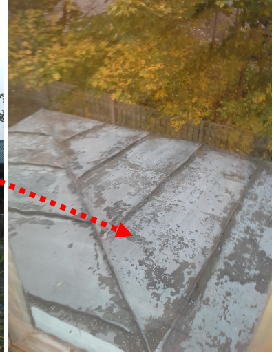
Kuvat 70 ja 71. Yleiskuva rakennuksen korkean osan vesikatosta, joka on uusittu ja lumiesteet on asennettu katolle. Alemmalla lappeella erkkerin katossa on pinnoitevaurioita ja se on selvästi vanhempaa katon osaa.
