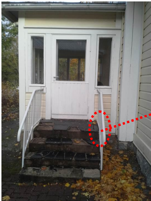
Kuvat 11 ja 12. Rakennuksen lounaispuolen erkkerin sisäänkäynnin reunassa on lahonnutta julkisivulaudoitusta ja reikä, josta sadevedet pääsevät suoraan rakenteen sisään. Samassa kohdassa rakennuksen sisäpuolella havaittiin ulkoseinän alaosan olevan märkä ja puuosat lahovaurioituneita.
