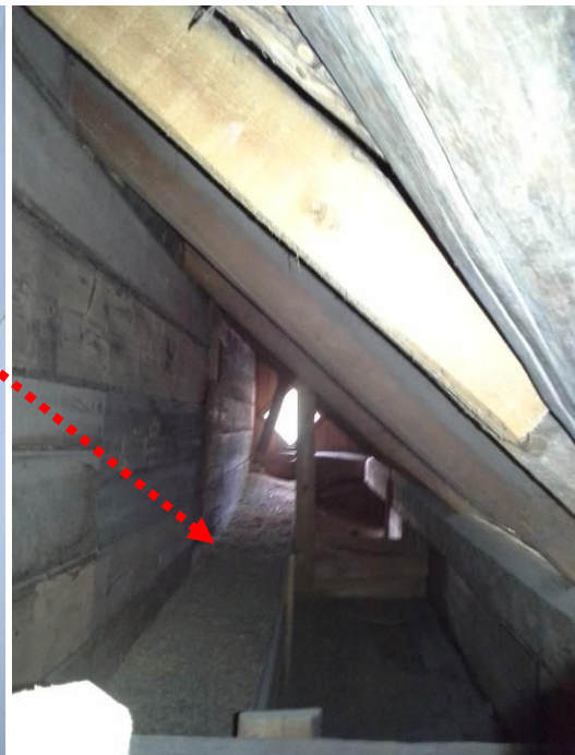
Kuvat 38 ja 39. Rakennuksen 2. kerroksen ulkoseinän avaus ullakkotilaan. Rakenteen purutäyttö ja puuosat olivat kuivia eikä aistinvaraisesti todettu merkkejä vaurioitumisesta. Rakenteessa oleva tervapaperi haisi voimakkaasti PAH-yhdisteille. Rakenneavauksesta päästiin näkemään taustalla oleva ullakkotila, johon ei ollut kulkua. Kyseisen avauksen kohdalle olisi hyvä tehdä tarkastus-/kulkuluukku ullakkotilaan.
