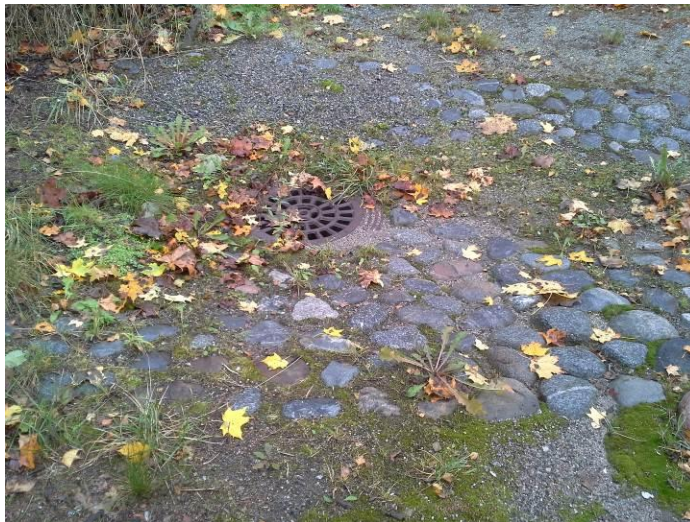
Kuva 19. Pohjois-/luoteispuolen piha-alueella on ritaläkännellinen sadevesikaivo.
