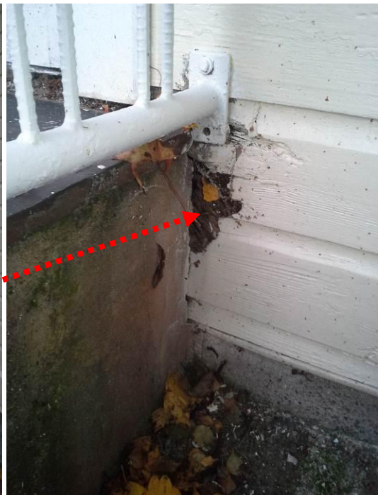
Kuvat 11 ja 12. Rakennuksen lounaispuolen erkkerin sisäänkäynnin reunassa on lahonnutta julkisivulaudoitusta ja reikä, josta sadevedet pääsevät suoraan rakenteen sisään. Samassa kohdassa rakennuksen sisäpuolella havaittiin ulkoseinän alaosan olevan märkä ja puuosat lahovaurioituneita.
