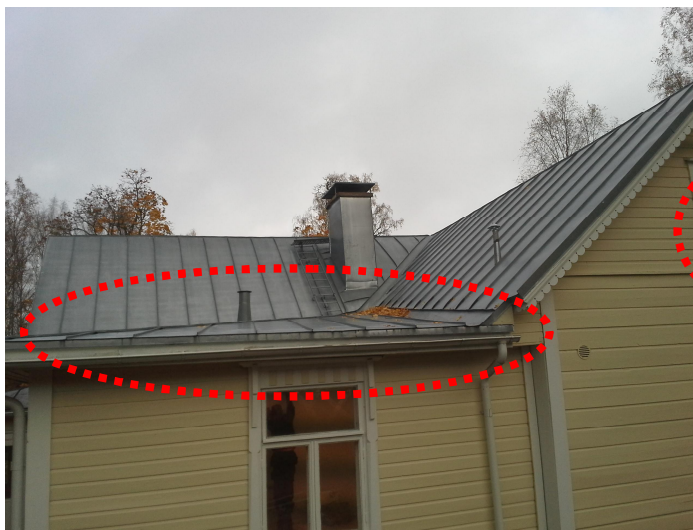
Kuvat 72 ja 73. Vasemmassa kuvassa loiva katon osan vesikate on uusittu ja alle on asennettu aluskermi. Oikeassa kuvassa on pääsisäänkäynnin erkkerin katto, joka on selvästi loivempi kuin korkean osan katto.
