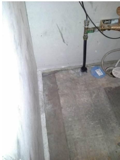
Kuvat 57 ja 58. Lämmönjakohuoneen lattia on betonirakenteinen. Lämmitysmuotona on öljylämmitys. Tilassa oli tunkkainen öljymäinen haju ja tilan ovi ei ole tiivis eli ilmaa kulkeutuu lämmönjakohuoneesta muihin tiloihin. Lattian rakenteissa oli runsaasti epätiiveyskohtia. Merkkisavulla ei havaittu voimakkaita ilmavirtauksia rakenteesta sisätiloihin, mutta ilma liikkui merkkisavulla tarkastettuna lämmönjakohuoneesta viereiseen käyttötilaan päin. Lattian betonilaatan pinnasta (syvyys 0...20 mm) otettu materiaalinäyte sisältää herkemmin haihtuvia öljyhiilivetyjä, jotka aiheuttavat tiloihin öljyn hajua.
