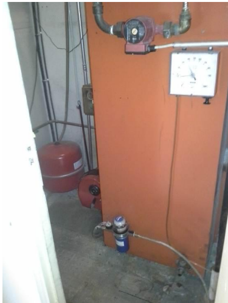
Kuvat 57 ja 58. Lämmönjakohuoneen lattia on betonirakenteinen. Lämmitysmuotona on öljylämmitys. Tilassa oli tunkkainen öljymäinen haju ja tilan ovi ei ole tiivis eli ilmaa kulkeutuu lämmönjakohuoneesta muihin tiloihin. Lattian rakenteissa oli runsaasti epätiiveyskohtia. Merkkisavulla ei havaittu voimakkaita ilmavirtauksia rakenteesta sisätiloihin, mutta ilma liikkui merkkisavulla tarkastettuna lämmönjakohuoneesta viereiseen käyttötilaan päin. Lattian betonilaatan pinnasta (syvyys 0...20 mm) otettu materiaalinäyte sisältää herkemmin haihtuvia öljyhiilivetyjä, jotka aiheuttavat tiloihin öljyn hajua.
