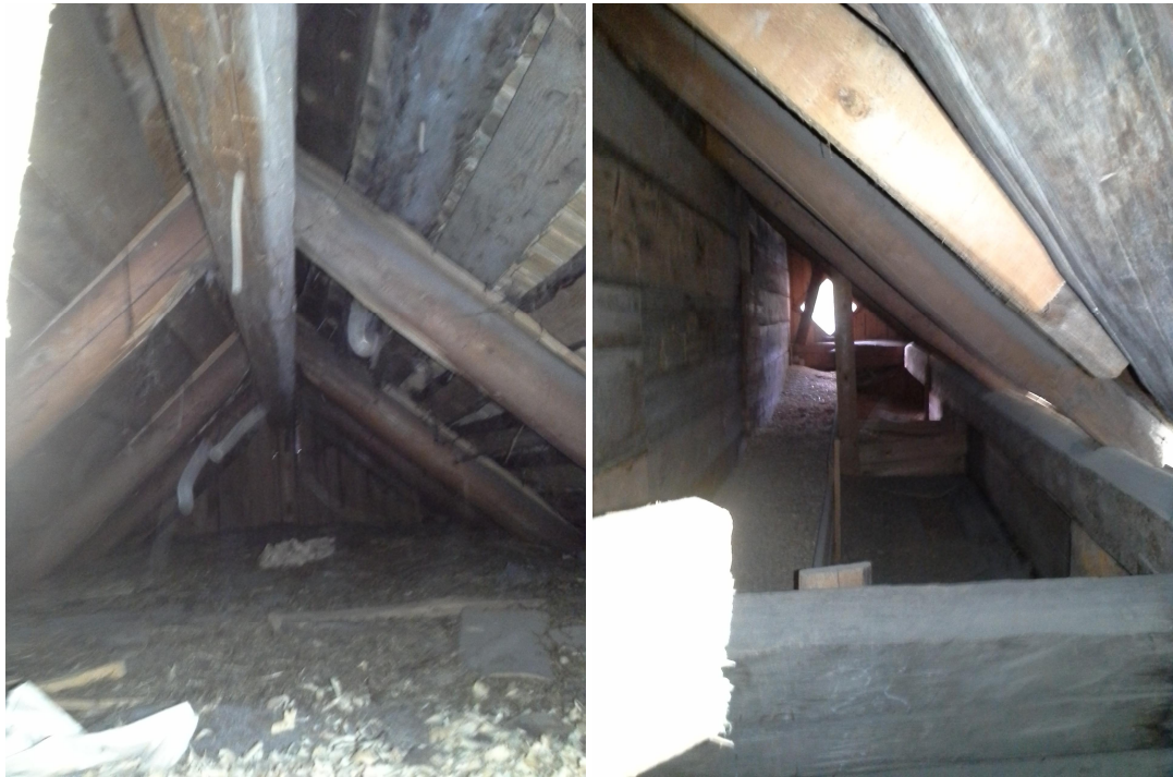
Kuvat 74 ja 75. Vasen kuva rakenneavaus RAK 9 (2.kerros) ja oikea kuva on rakenneavaus RAK 5. Rakennuksen korkean osan ullakko rakenneavauksien kautta tarkastettuna. Ullakko pääsee tuulettumaan räystäiltä ja julkisivulle on lisätty korvausilmasäleikköjä. Vinon katon reunassa olevassa ullakossa on ikkuna päädyssä. Vanhoissa puurakenteissa ei havaittu vauriojälkiä eli puuosat olivat lähinnä tummentuneet ikääntymisen seurauksena.
