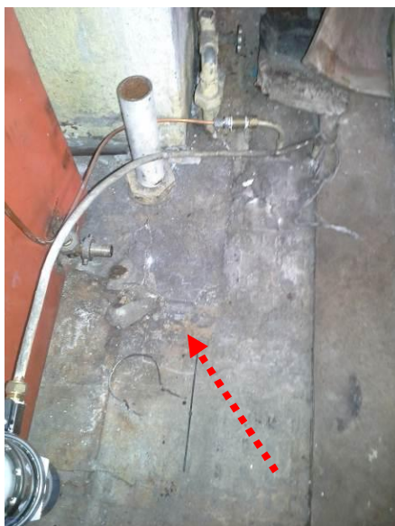
Kuva 62. Haitta-ainenäytteenottopiste lämmönjakohuoneen lattian betonista.
