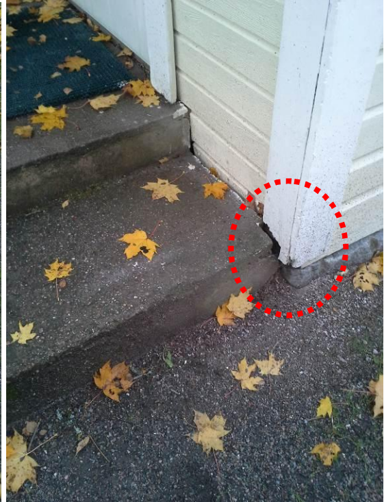
Kuvat 20 ja 21. Pääsisäänkäynnin erkkerin nurkkalaudoitusten alaosan puut ovat lahovaurioituneet. Vaurioituneet kohdat on ylimaalattu.
