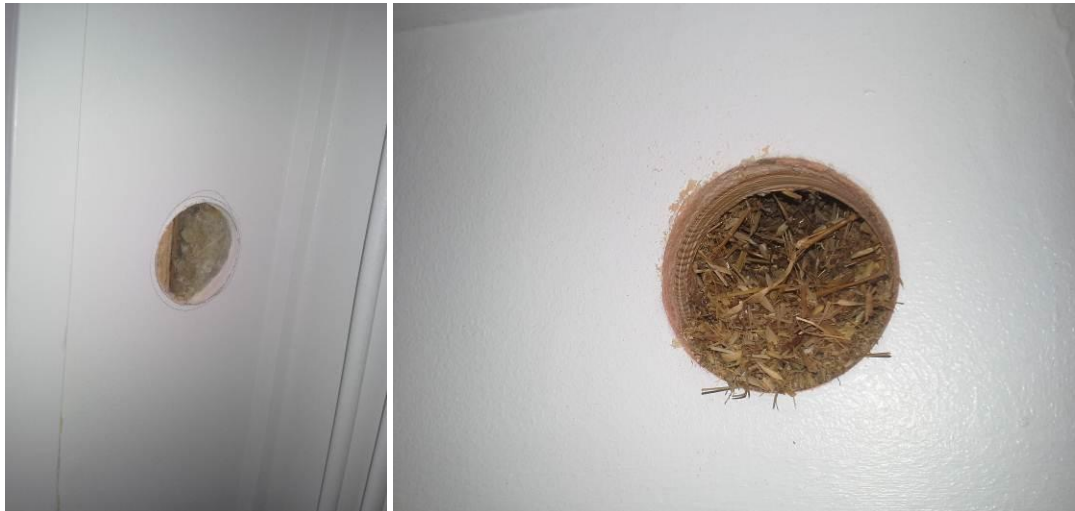
Kuvat 24 ja 25. Ulkoseinän sisäpuoliset rakenneavaukset RAK 2 (vasen kuva) ja RAK 11 (oikea kuva). Alakerrassa lisälämmöneristeenä on käytetty mineraalivillaa ja yläker-rassa olkea.
