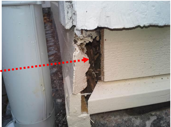
Kuvat 9 ja 10. Rakennuksen etelän puoleisessa kulmassa havaittiin julkisivulaudoituksen takana lahonnutta puurakennetta. Kyseisessä kohdassa julkisivuverhouksen sauma oli auki, jonka kautta sadevesi on päässyt rakenteeseen. Oikean puolen kuvassa näkyy, että luonnonkivisokkelin päällä hirsirungon alapuolella on kermikaista.
