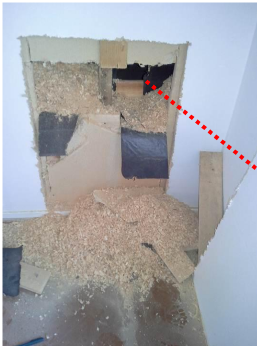
Kuvat 38 ja 39. Rakennuksen 2. kerroksen ulkoseinän avaus ullakkotilaan. Rakenteen purutäyttö ja puuosat olivat kuivia eikä aistinvaraisesti todettu merkkejä vaurioitumisesta. Rakenteessa oleva tervapaperi haisi voimakkaasti PAH-yhdisteille. Rakenneavauksesta päästiin näkemään taustalla oleva ullakkotila, johon ei ollut kulkua. Kyseisen avauksen kohdalle olisi hyvä tehdä tarkastus-/kulkuluukku ullakkotilaan.
