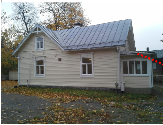
Kuvat 70 ja 71. Yleiskuva rakennuksen korkean osan vesikatosta, joka on uusittu ja lumiesteet on asennettu katolle. Alemmalla lappeella erkkerin katossa on pinnoitevaurioita ja se on selvästi vanhempaa katon osaa.
