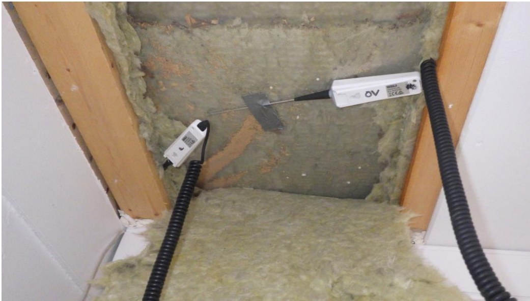
Kuva 5. Rakenneavaus 1 ensimmäisen kerroksen salissa 2.
