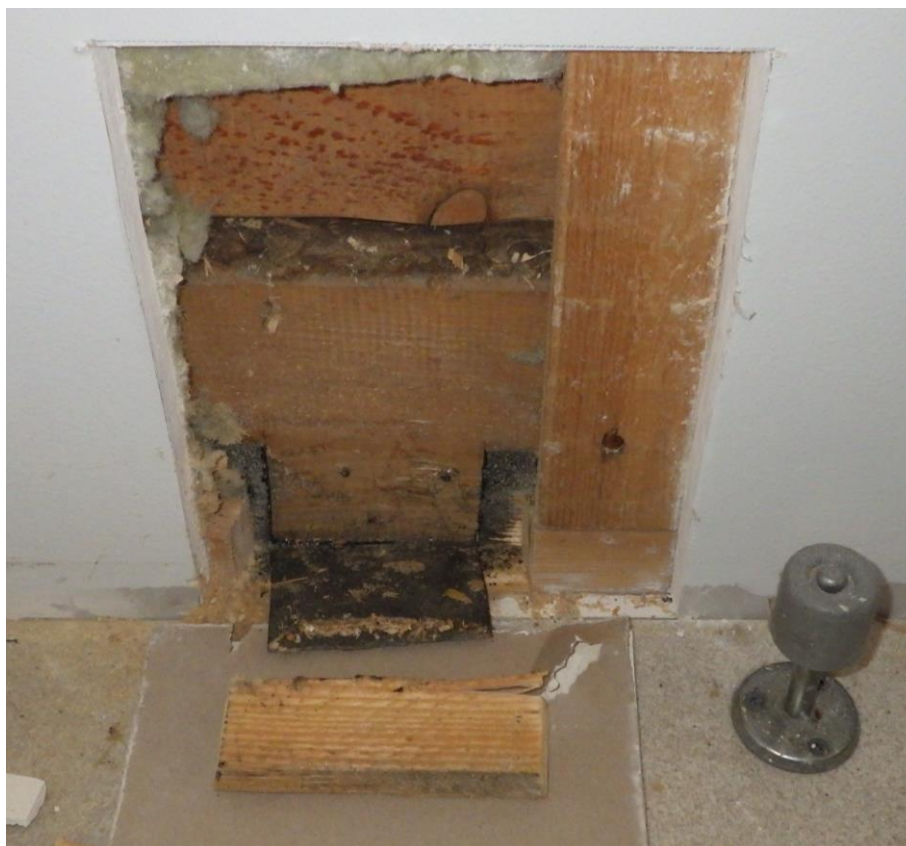
Kuva 7. Rakenneavaus 3 ensimmäisen kerroksen salissa 2.
