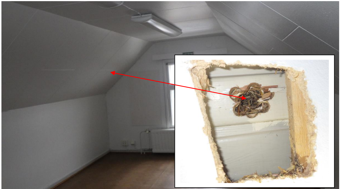
Kuva 6. Rakenneavaus 2 toisen kerroksen makuuhuoneessa 1.
