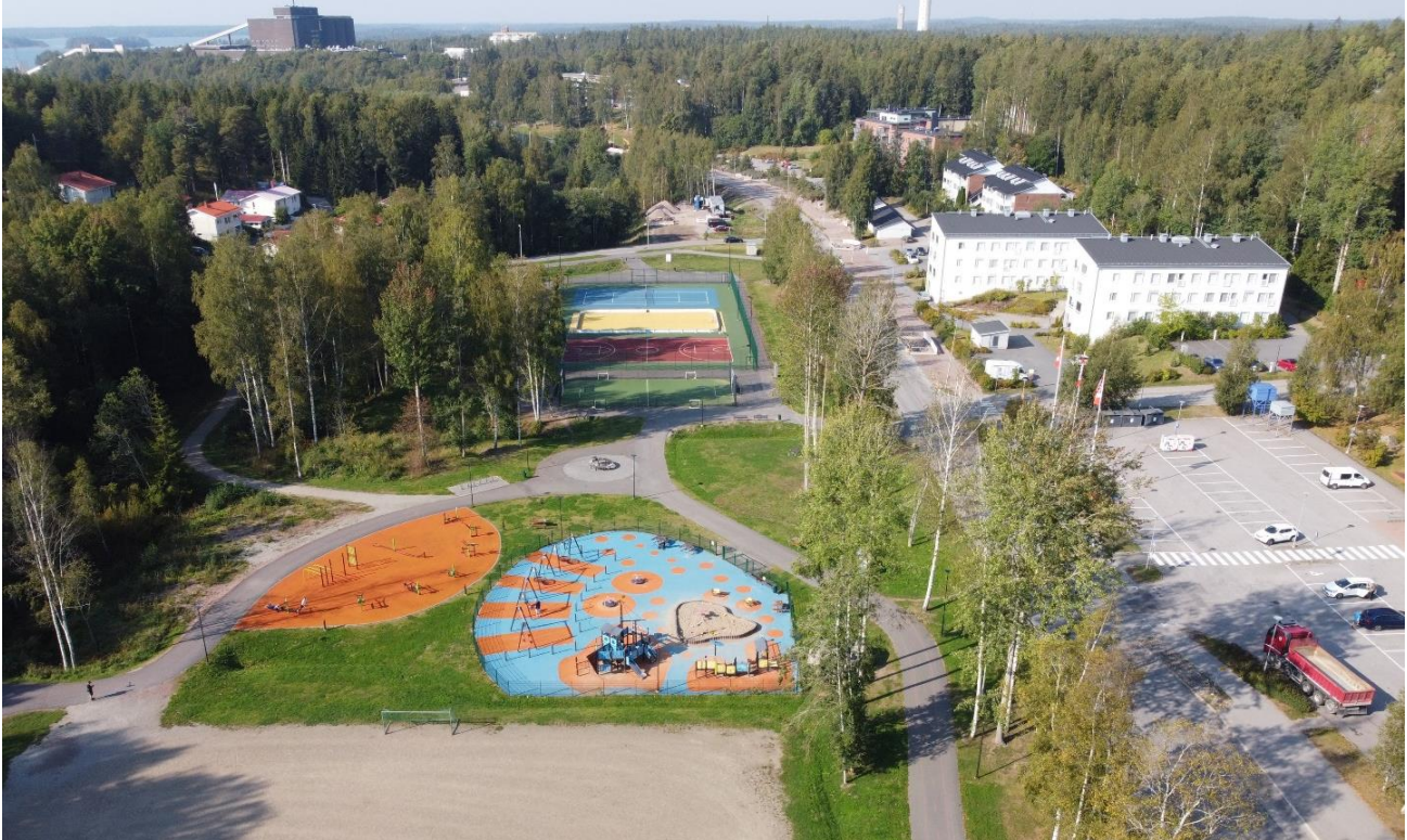
Kuva 36. Kantvikin keskustan Sokeritehtaantien varsi edustaa keskustatoimintojen aluetta (C) sekä asuntoalueiden osalta vyöhykkeen 2 mukaista aluetehokkuutta.
