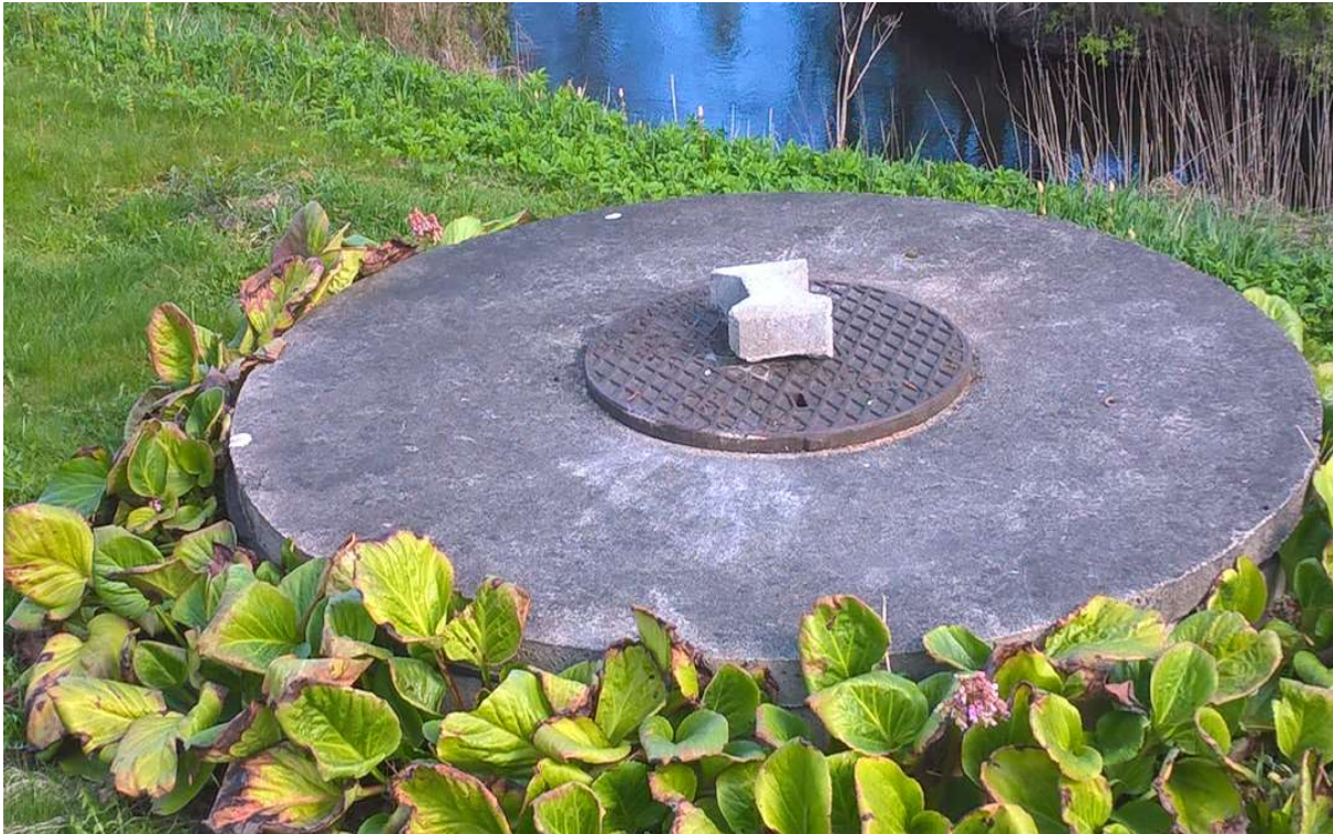
Umpikaivo jätevesille. (LUVY / Virve Ståhl)
