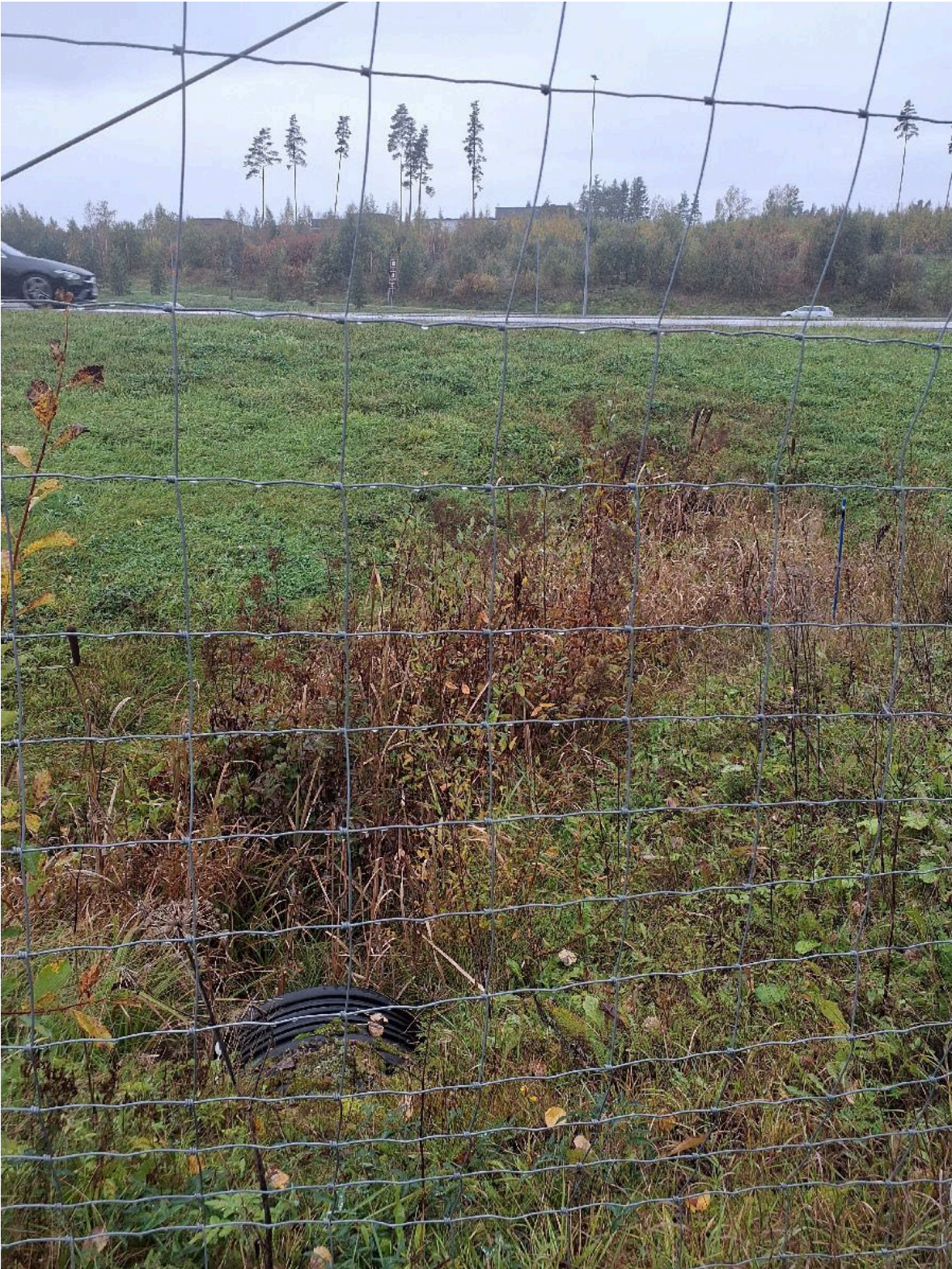
Kuva 16 uoma kulkee putkessa moottoritien ali.
