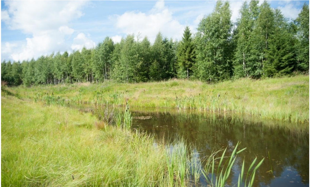
Kuva 15: Tiiviimmin rakennetun alueen hulevesipainanteen luonnemalli. Tässä mallissa on pysyvä vedenpinta (Lähde: Ramboll Finland).
