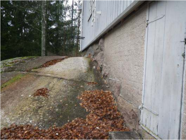
7. Kalliopinta viettää poispäin rakennuksesta
