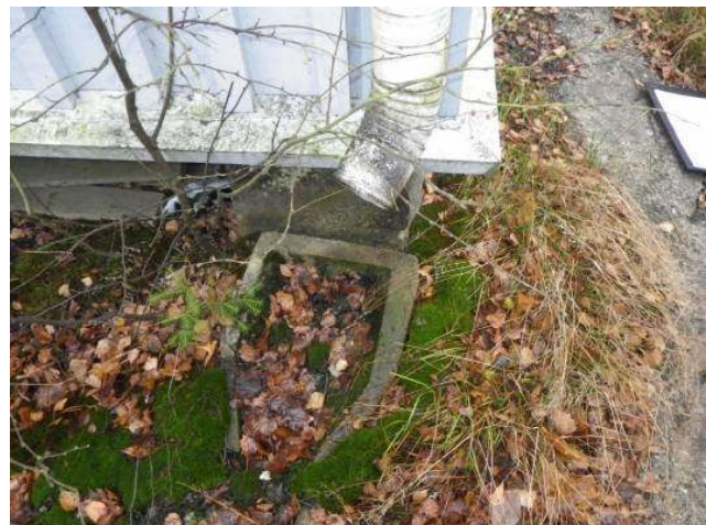
9. Sadevesien poisjohtamista oikeassa etukulmassa
