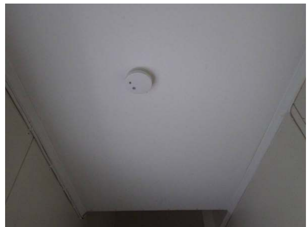
89. ...on korvattu paristokäyttöisillä palovaroittimilla.
