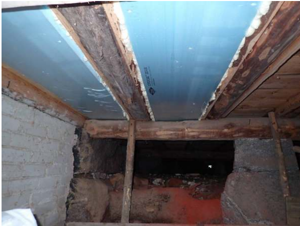
26. Alapohjarakennetta on korjattu tai lisäeristetty.
