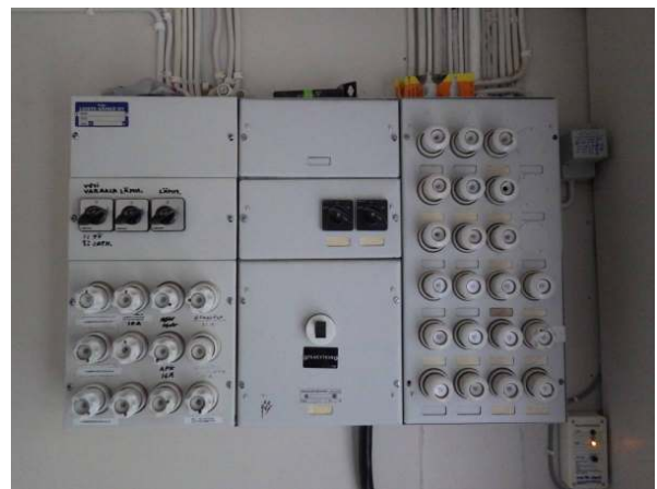
77. Sisällä oleva vanha keskus toimii ryhmäkeskuksena.
