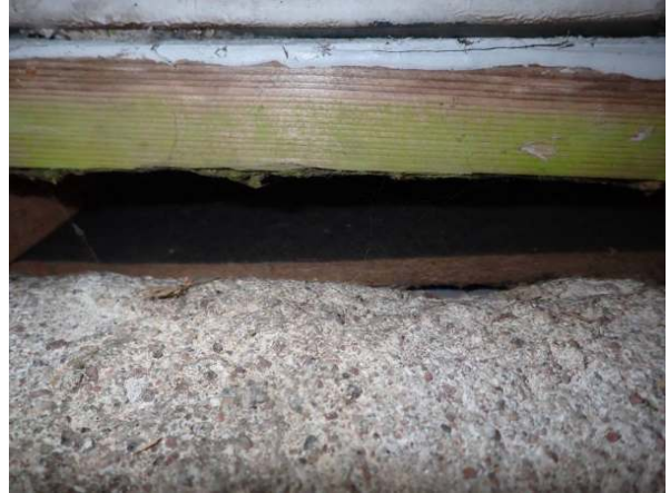
31. Ulkoseinässä on tuuletusrako
