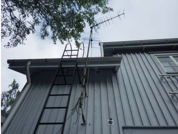
87. Harava-antenni rakennuksen katolla.
