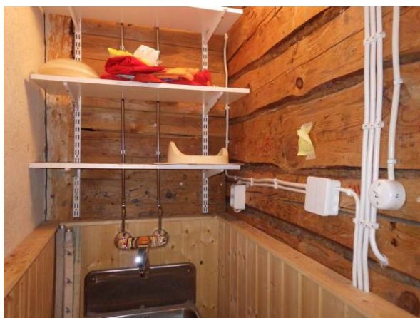
81. Sähkökalusteita eri aikakausilta.
