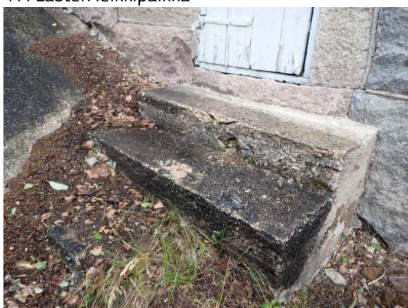
19. Alapohjatilaan johtava porrasaskelma.
