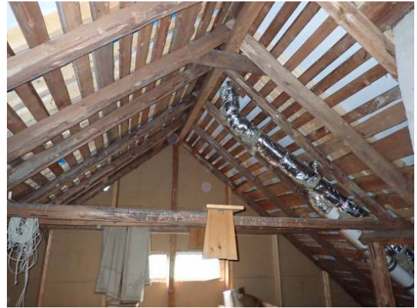
51. Katon alapuolella olevaa laudoitusta.
