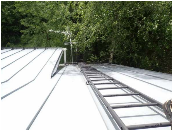
44. Katolla on uusitut lapetikkaat.
