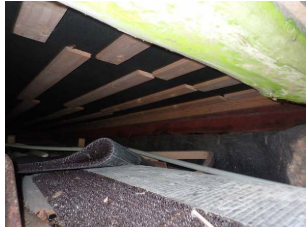
25. Alapohjarakennetta on uusittu kuistin alapuolelta.
