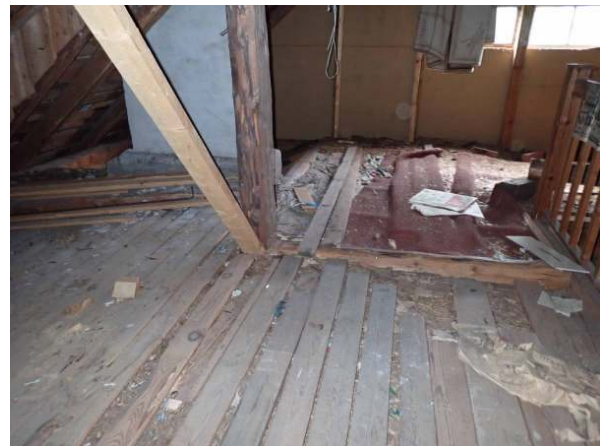
53. Yläpohjarakenteen päällä on osittain laudoitusta.
