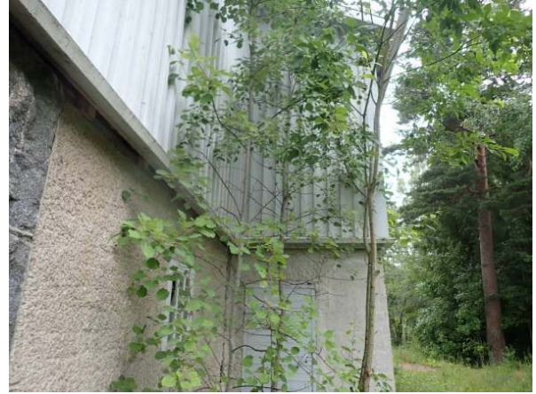
6. Kasvillisuus on hiukan liian lähellä rakennusta.
