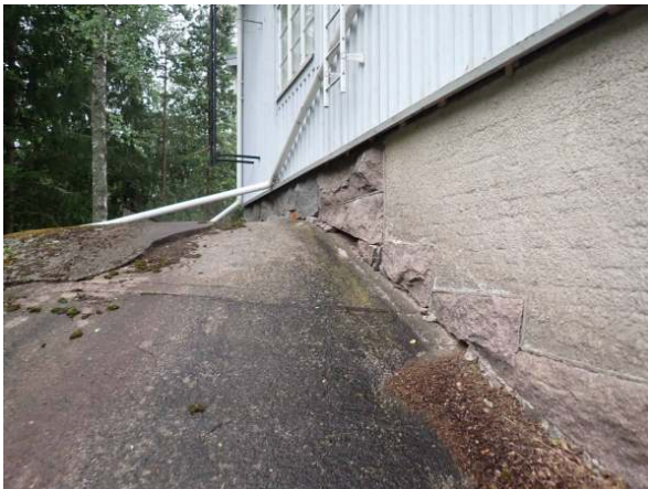
1. Rakennuksen vierustalla on laajalti kalliota.
