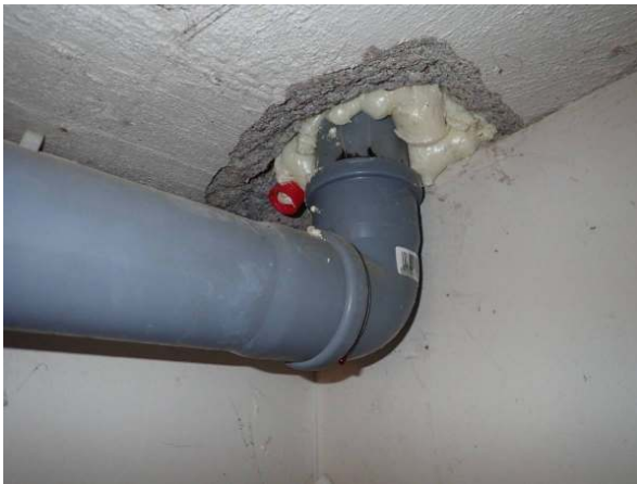
63. Viemärit ovat muovia.
