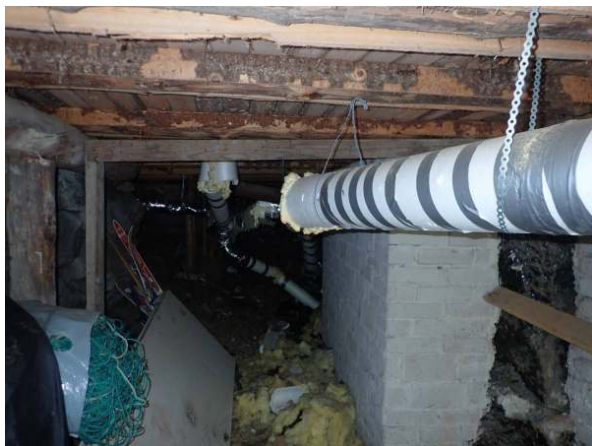
69. Alapohjan viemärit on eristetty.
