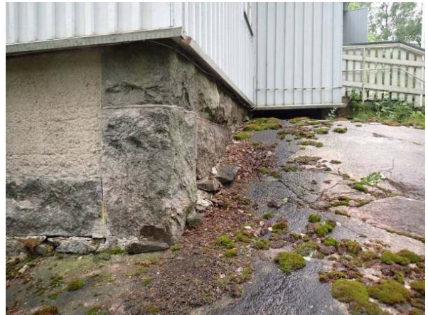
23. Perustuksia on asennettu kallion päälle.
