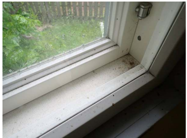
37. Ikkunarakennetta uusitun ikkunan osalla.
