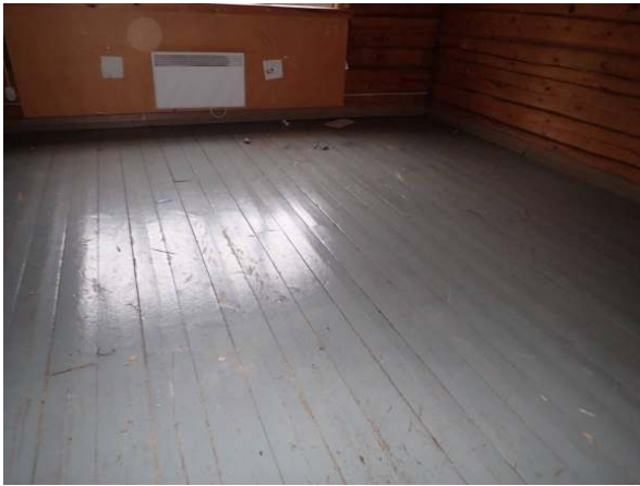
54. Sisätiloissa on laualattiaa.
