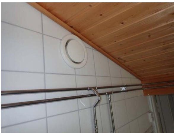
71. Poistoilmaventtiili.
