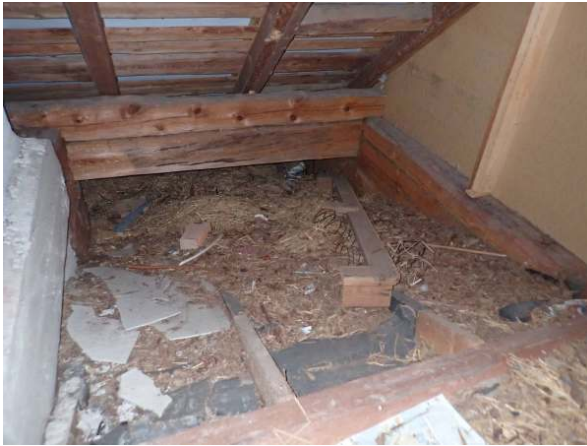
50. Yläpohjatilassa on eristeenä eri vanhoja materiaaleja.
