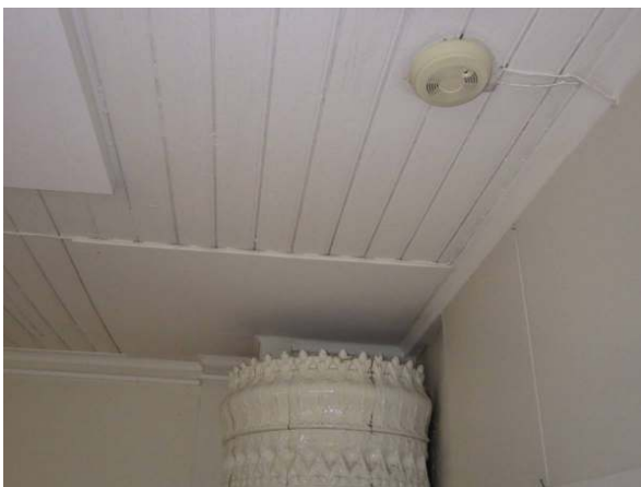
88. Vanha palovaroitinjärjestelmä...
