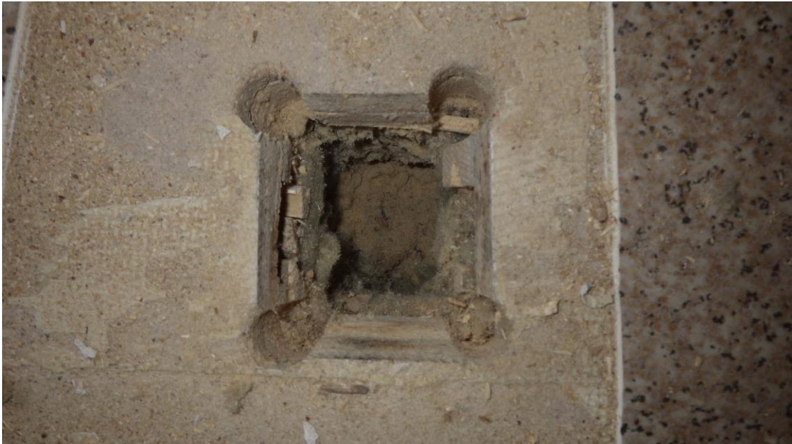
Kuva 8. Rakenneavaus RA3 isossa salissa (näyttenumero 3, ei mikrobikasvua).
