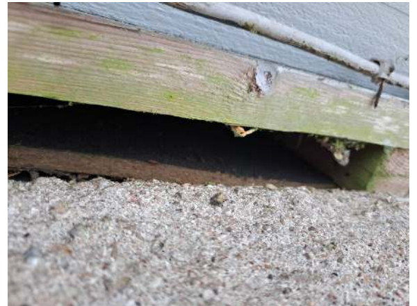
30. Tuuletusväliä verhouksen takana.
