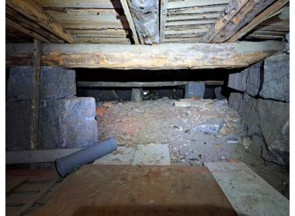
17. Kuvaa tuulettuvasta alapohjatilasta.
