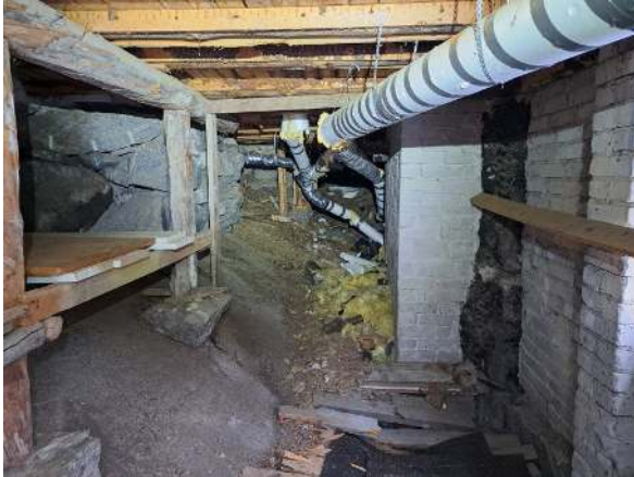
16. Kuvaa tuulettuvasta alapohjatilasta.
