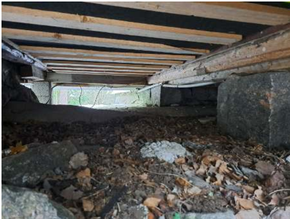
18. Kuvaa tuulettuvasta alapohjatilassa sisäänkäynnin alta.
