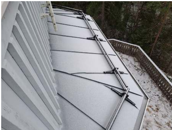
44. Terrassin osan kattoa.
