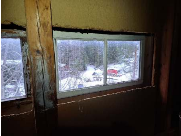
36. Ullakkotilassa vanhat ikkunat.
