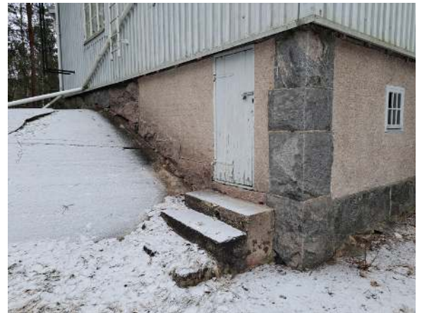
41. Alapohjaan johtava ovi.
