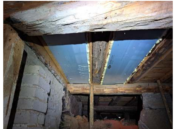
19. Alapohjan rakenteita korjattu.
