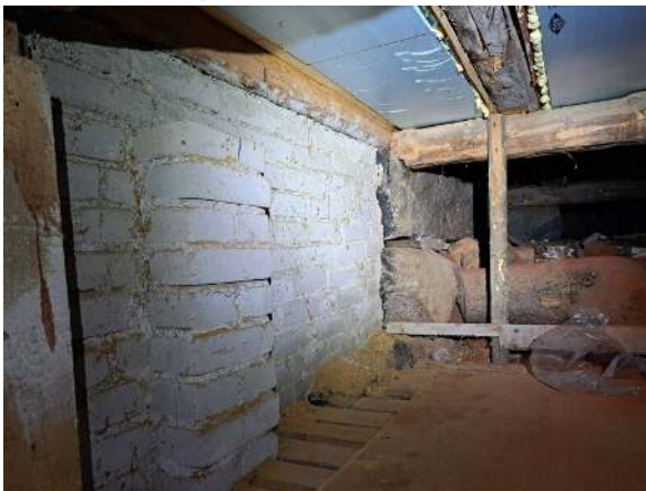
14. Perustuksia talon alla.
