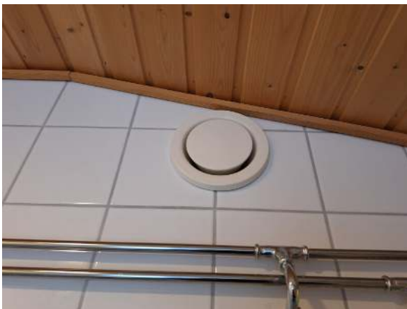
79. Pesuhuoneen poistoventtiili.
