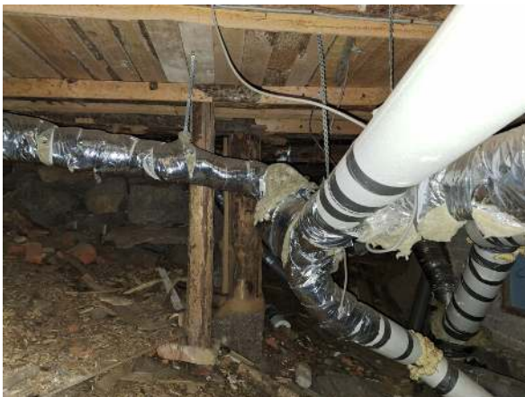
77. Viemärien eristystä talon alla.
