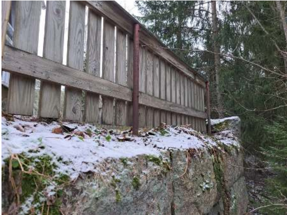
10. Aitalopat ruostuneet. Puuosat ovat maalaamattomia.
