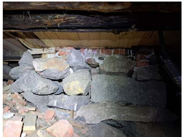
15. Perustuksia talon alla.
