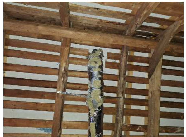
78. Viemäriin tuuletusputken eristys.
