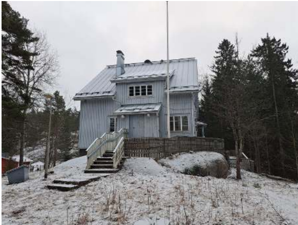
1. Rakennus sijaitsee kallion päällä muuta maastoa korkeammalla.
