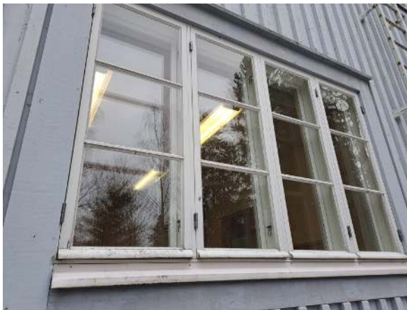
32. Ikkunat ovat MSE -tyyppiset. Ulkopinta on puurakenteinen.
