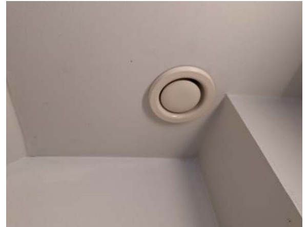
82. Poistoilmaventtiili.
