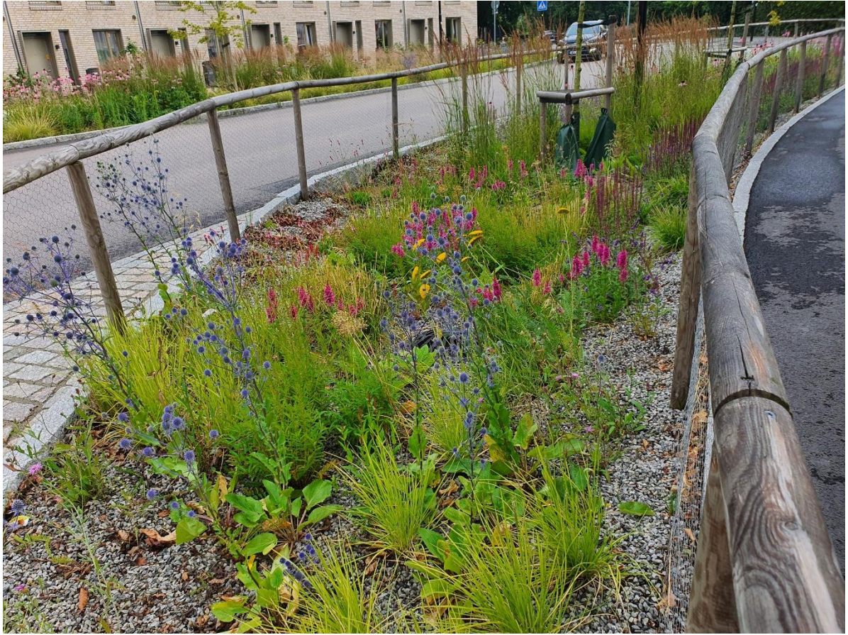
Kuva 16: Katutilaan sopivan hulevesipainanteen luonnemalli. (Kuvaus: Z. Hrasko-Johnson).
