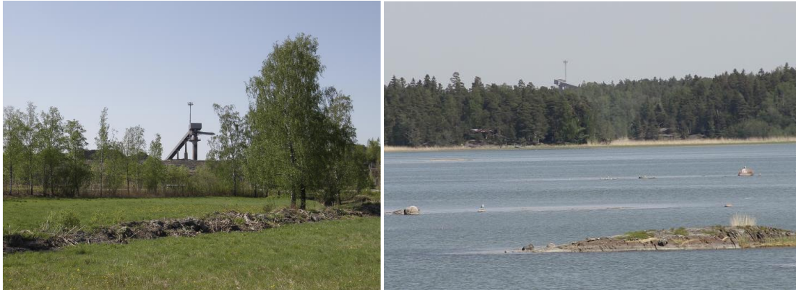
Kuva 24. Vasemmalla satamassa oleva hiilikentälle johtava kuljetin kuvattuna Stor-Olarsin peltoaukean yli luoteesta. Oikealla sama kuljetin kuvattuna Kors Sundetin sillalta Espingsfjärdenin yli lounaasta. Hiilikuljettimen korkein kohta on 46 m merenpinnan yläpuolella, hiilikentän pohjan taso puolestaan 16 m merenpinnan yläpuolella. Kuvat: FCG, Minttu Kervinen, 24.5.2023.
