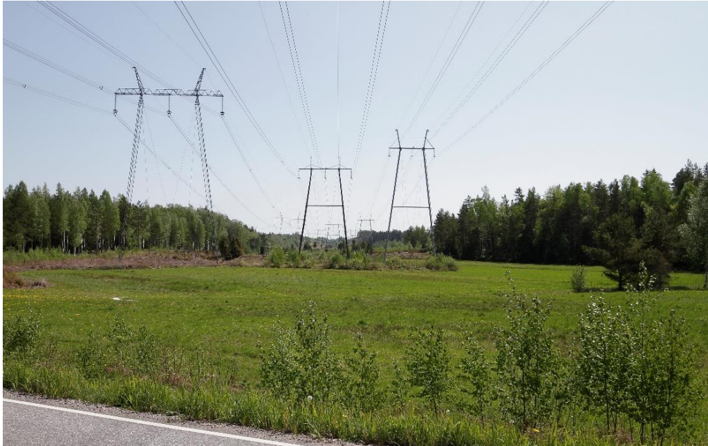
Kuva 59. Näkymä kohti kaava-aluetta Fagervikin tieltä luoteeseen johtavan voimalinjan alta. Maastonmuotojen vuoksi kaava-alueen nykyinen rakennuskanta ei näy paikalle. Kaava-alueella olleen hiilivoimalaitoksen piiput ja kattilahuoneet näkyvät paikalle ennen niiden purkamista. Kuva: FCG, Minttu Kervinen, 24.5.2023.
