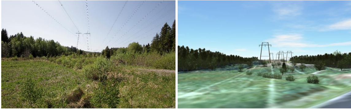
Kuva 54. (Vasemmalla) Näkymä kohti kaava-aluetta Fagervikintieltä koilliseen johtavan voimalinjan alta. Maastonmuodot estävät suoran näköyhteyden Stormossenille. Kaava-alueella olleen hiilivoimalaitoksen piiput näkyvät paikalle ennen niiden purkamista. Kuva: FCG, Minttu Kervinen, 24.5.2023.
