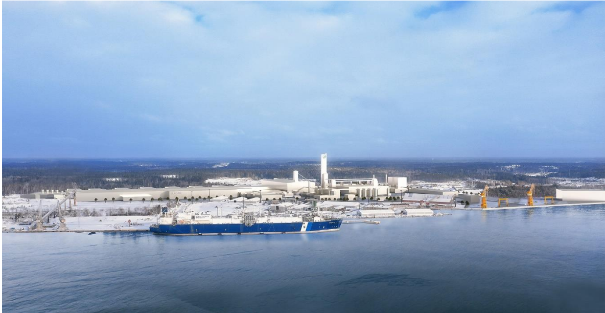
Kuva 45. Havainnekuva suunnitellusta vihreän teräksen tehtaasta ja sitä ympäröivästä alueesta. Tehdasalueen keskellä näkyy noin 140 metriä korkea suorapelkistysuuni, jossa rautamalmipelletit pelkistetään vedyn avulla rautasieneksi.
