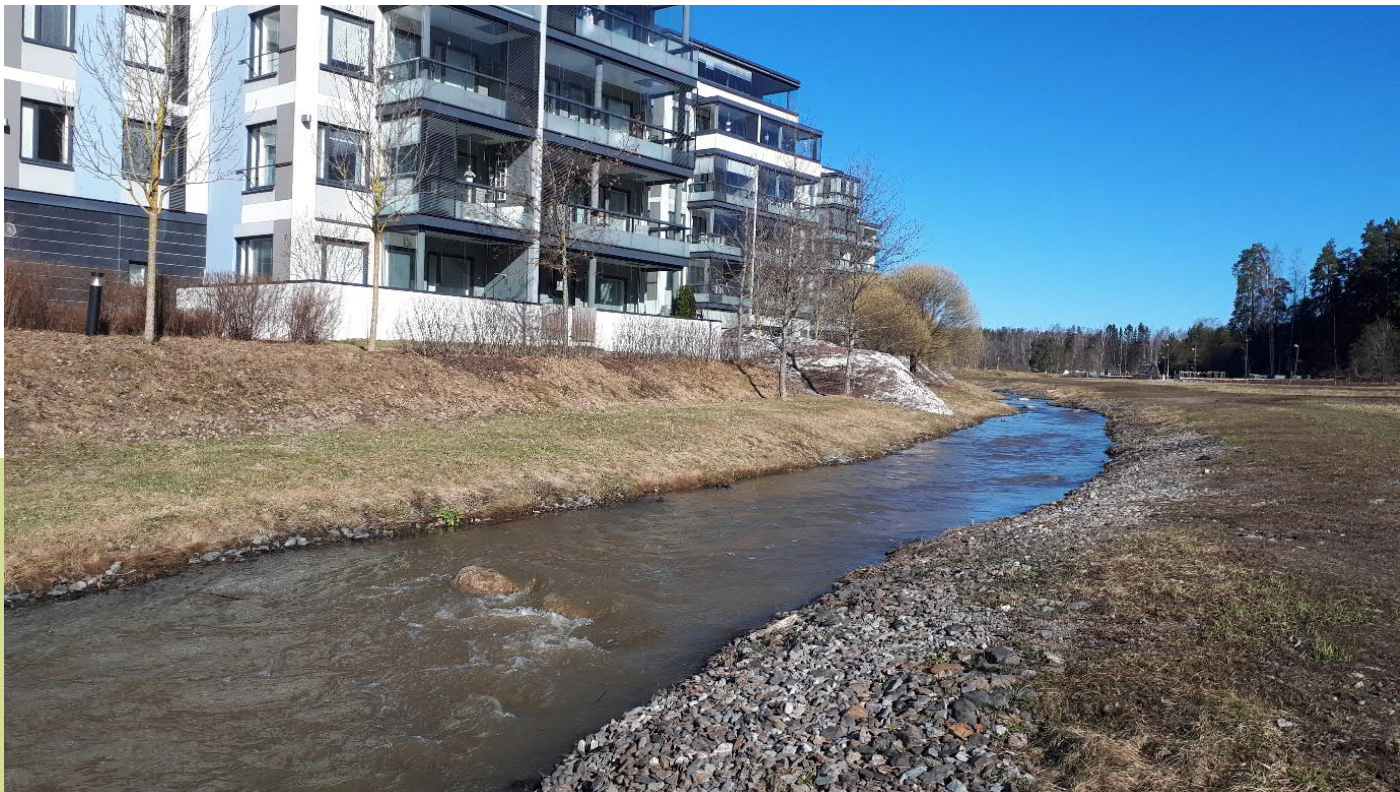
Kuva 8. Jolkbyån-puroa Kirkkolaaksossa Kirkkonummen keskustassa. Uomaa on siirretty rakentamisen alta 2000-luvun alussa. Tällöin uoman pohjalle laitettiin särmikästä louhetta, joka ei sovellu vaelluskalojen liikkumiselle. Jolkbyånin uomaa on sittemmin kunnostettu Virtavesien hoitoyhdistys ry:n ja Kirkkonummen ympäristöyhdistys ry:n sekä talkoolaisten toimesta. Kuva: Kirkkonummen kunta.
