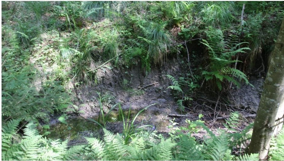
Kuva 1 Metsäiseltä alueelta tulevissa valtaojissa on havaittavissa selkeitä eroosion merkkejä.
