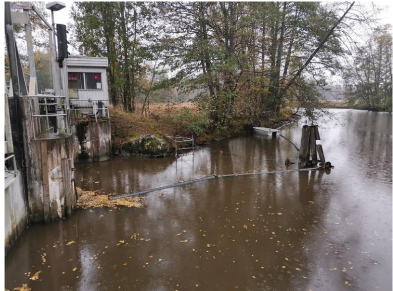
Kuva 24. Pikkalan säännöstelypadon yläpuolelle asennettu DIDSON-viistokaikuluotain asennustelineineen. Kaikuluotaimen yläpuolella oli pyynnissä luokkirysä. (LUVY / Jussi Vesterinen)
