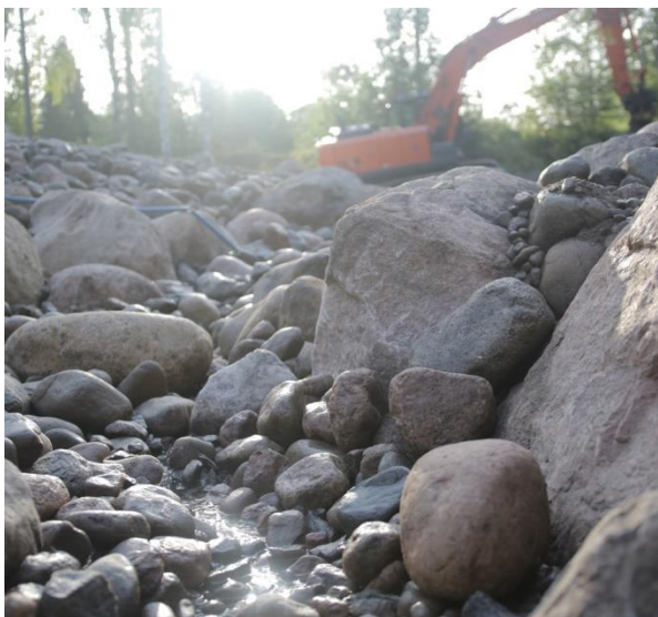
Kuva 19. Oravabäckenin munkkipadon ohitusuoman rakennustyöt syksyllä 2023 (LUVY / Joonas Tammivuori).
