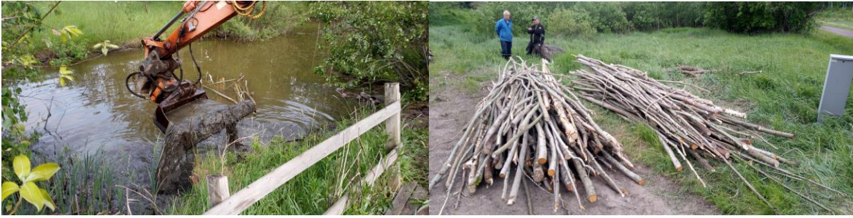
Kuva 12. Riilahden kosteikkoallasta mm. muokattiin kosteikkokasvillisuudelle suotuisammaksi ja puhdistustehoa pyrittiin lisäämään kosteikkoon asennetuilla puunipuilla (LUVY / Mikko Melasniemi).
