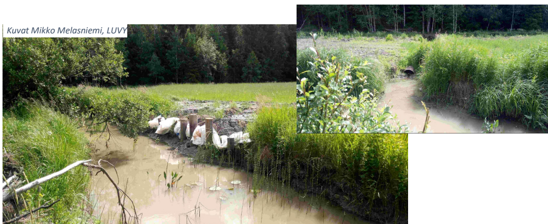
Kuvat Jaksolla 5 on lähiaikoina tehty eroosiosuojausta sekä ilmeisesti Degermossensuon valumavesien ohjauksen kunnossapitotoimenpiteitä.
