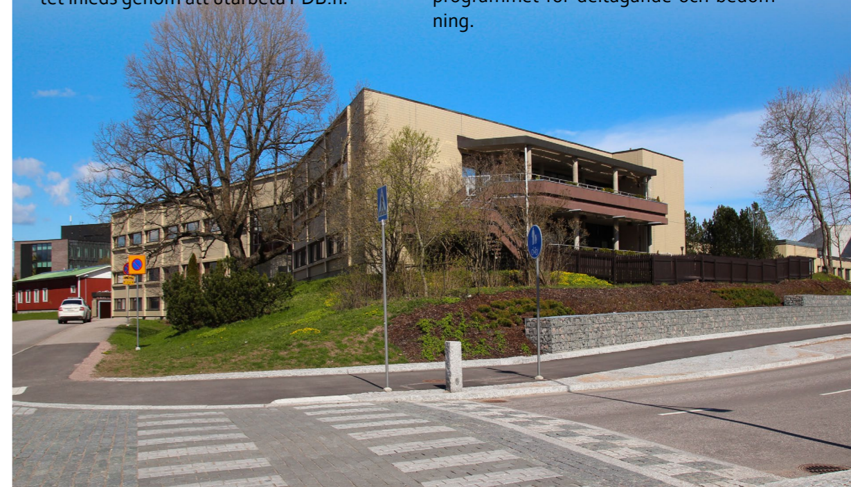
Gamla hälsocentralen väntar på rivning.
