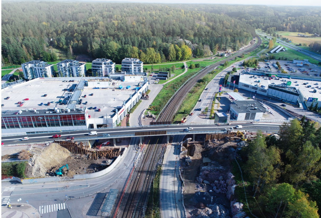
Kyrkslättsvägens bro färdigställs före utgången av år 2024.
