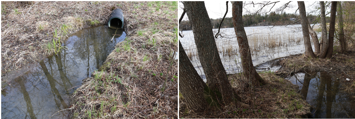
Kuva 40. Rantatien hulevesiputken ja Kaljärven välissä ei ole paljon tilaa.
