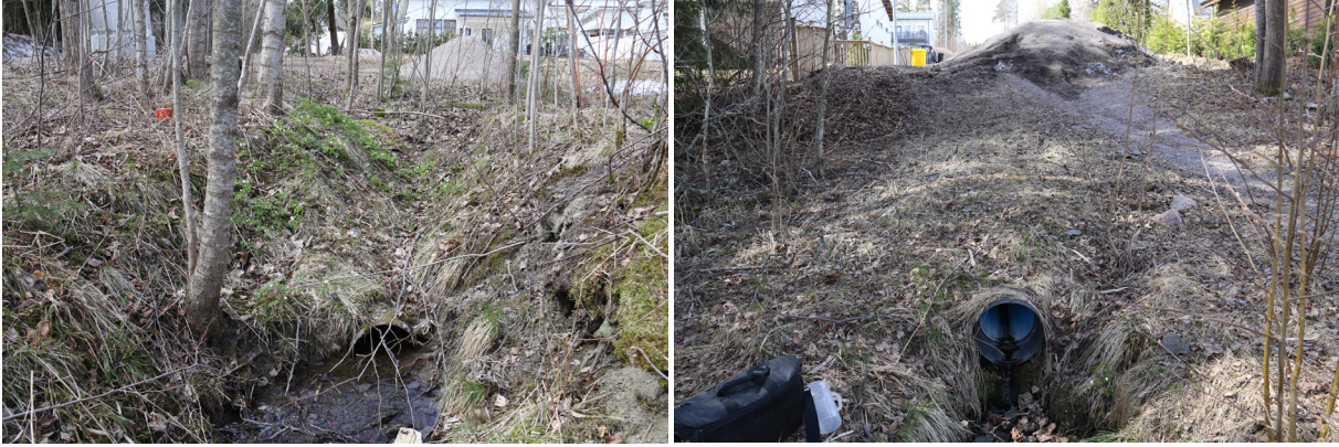
Kuva 13. Vasemmalla Lammaskalliontien ja oikealla Kulotien hulevesiverkoston purkuputkien päät.
