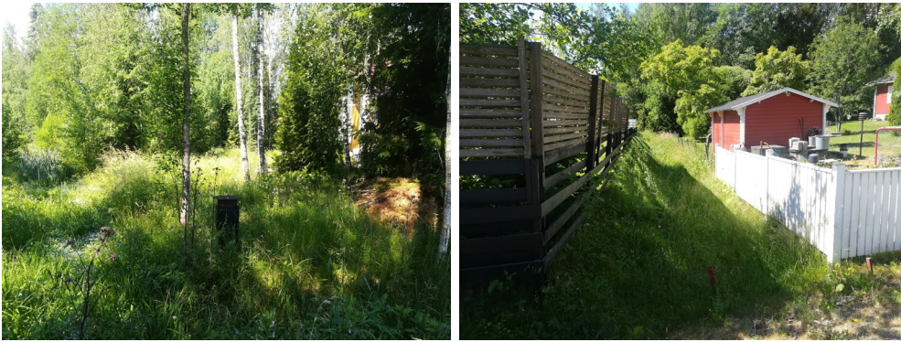
Kuva 55. Kullervontien päässä avo-ojat sijaitsevat hyvin lähellä kiinteistöjä. Kuvassa vasemmalla kiinteistön eteläpuolinen oja, johon Männistöntien oja liittyy. Oikealla siihen liittyvä saman kiinteistön länsipuolella kulkeva oja.
