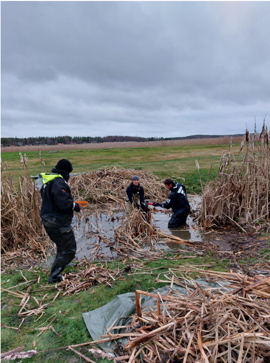
Kuva 13. Loppuvuonna 2022 toteutetut kunnostustalkoot ja pohjapadon rakentaminen sekä valmis pohjapato – keskelle uoma laitettiin filmivaneria ja reunoille kiviä. (LUVY / Maj Rasilainen )
