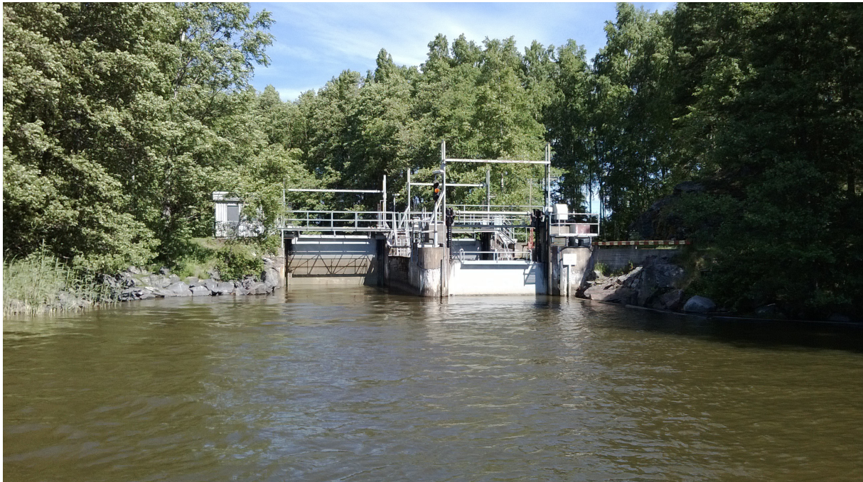
Kuva 1. Pikkalanjoen säännöstelypato ja venesulku Pikkalanlahden puolelta kuvattuna. (LUVY / Jorma Valjus)
