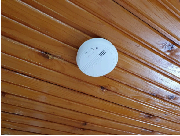
77. Tavallinen paristokäyttöinen palovaroitin.
