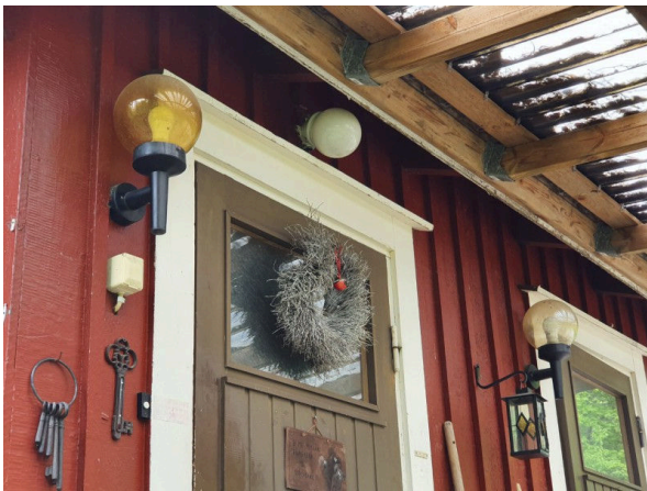
49. Rakenteisiin asennettuja valaisimia.
