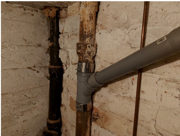
36. Viemäreitä on uusittu osittain.
