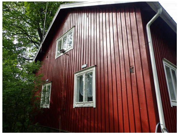
14. Julkisivut ovat tyydyttävässä kunnossa.
