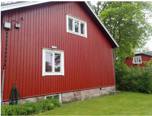
13. Julkisivut ovat tyydyttävässä kunnossa.
