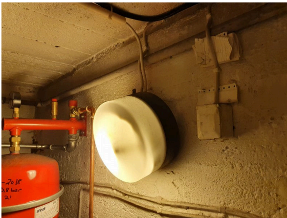
63. Lämmönjakuhuoneen valaisin tulee kiinnittää.
