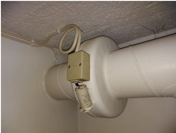
43. Saunaosaston kanavapuhallin.
