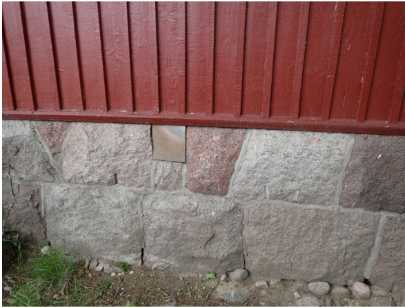
10. Tuuletusaukko on suljettu.
