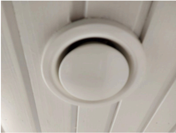
46. Poistoilmaventtiili.
