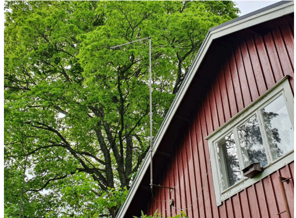
75. Harava-antennia ei ole maadoitettu.
