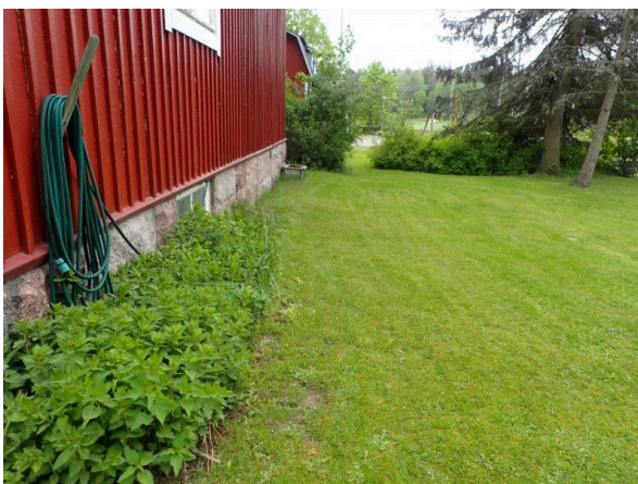
2. Kasvillisuutta sokkelissa kiinni.
