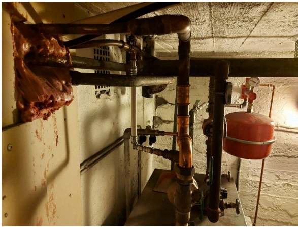
34. Vesijohdot ovat öljylämmityslaitteiston yhteydessä osin uusittua kuparia.
