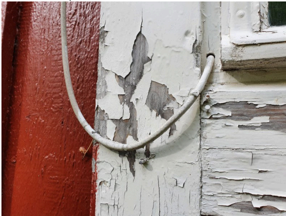
76. Antennijohdotus on tehty ulkoseinää pitkin.
