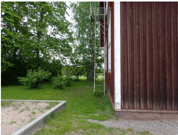
1. Rakennuksen vierusta on paikoin melko tasainen.
