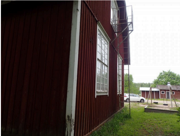
2. Yleiskuva rakennuksen vierustasta.
