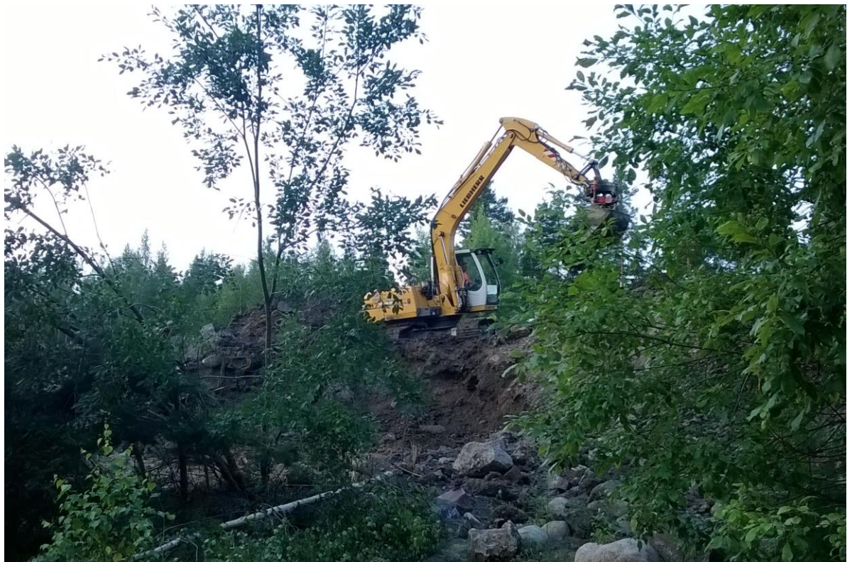
Kuva 4. Kaivutyön loppuvaihe. Lähes kaikki savimaa on kaivettu ylös.
