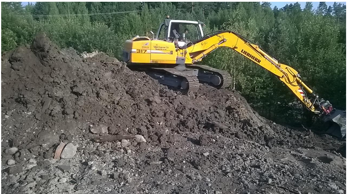
Kuva 3. Tilannekuva savimaan kaivutyöstä osoitteessa Ristinummentie XXXX .
