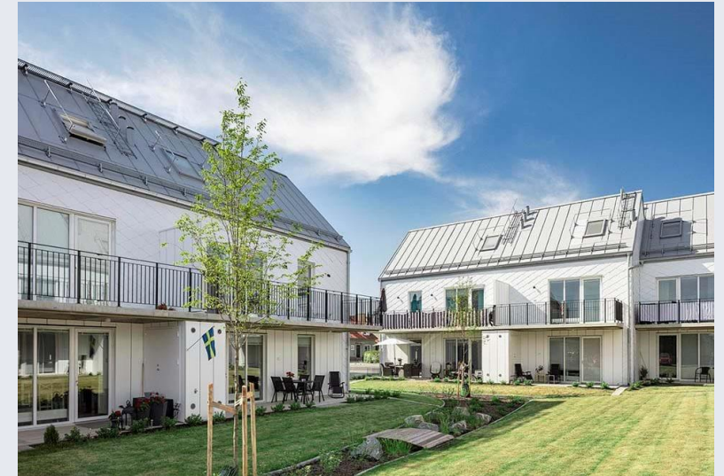
Esimerkki kylää vahvistavasta uudesta rakentamisesta, Sweco.
