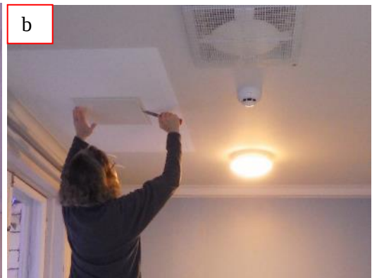
Kuvat 51 a ja b. Talotekniikka on asennettu alaslaskutilaan. Kartanon puolella alaslaskutilassa oli havaittavissa tympeä hajua ja pölyä (b).
