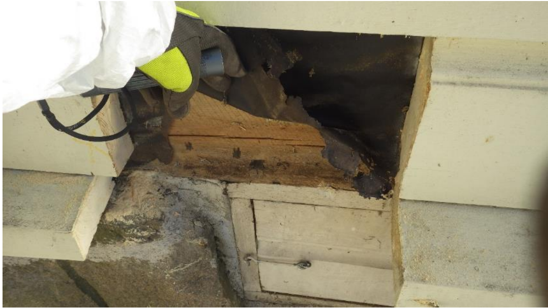
Kuva 43. Rakenneavauskohta RAK44. Tuulensuojana on tuohen sijaan tervapaperi. Hirsi oli kovaa. Alareunassa oli muutamia vanhoja hyönteisten lentoaukkoja.
