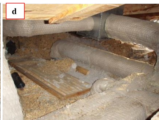
Kuvat 63 a-e. Siiven yläpohjatila. Lämmönjakohuoneen puoleisen päädyn yläpohjan täyttökerros oli lämmin ja koristeikkunan lasin sisäpinta oli sula. Länsipäädyssä puupinnoilla oli vanhoja vauriojälkiä ja puun tummumista vesikaton aluslaudoituksessa päätyräyställä (a), ikkunan lasipinta oli jäässä ja täyttökerros oli viileämpi. Seinän yläosaa on ilmeisesti korjattu (b). Täyttömateriaalina on mm. purua, savea, sammalta ja täytön päällä ei ole laudoitusta. Yläpohjatilassa on ilmanvaihtokanavistoa, joka on eristetty mineraalivillalla (d). Läpiviennit ovat epätiivit (c). Räystäät ovat ummessa, eikä yläpohjatila tuuletetu niiden kautta. Ikkunat olivat heikkokuntoiset.
