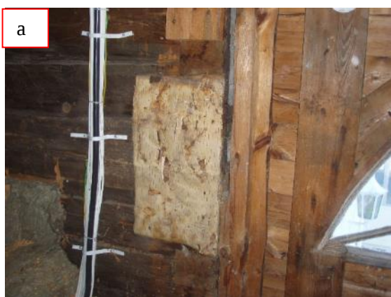
Kuvat 24 a ja b. Siipi ja kartano on rakennettu todennäköisesti eri aikaan. Kuvassa näkyy ilmeisesti kartanon vanha ulkoseinä, jossa tuulensuojana on tuohi ja pinta on mahdollisesti käsitelty kosteutta suojaavasti (a). Ulkoseinästä on tullut myöhemmin väliseinä, kun siipi on rakennettu. Siivessä on käytetty myös hirren pintakäsittelyä hirsien alaosissa, jonka lisäksi hirttä on hiiltynyt väliseinän alaosassa ilmeisesti palon seurauksena (b). Havainnot viittaavat eri rakennusajankohtaan, kun lisäksi huomioidaan, että siivessä käytetyt materiaalit, perusmuuri ja ikkunat ovat erilaiset kuin kartanossa.
