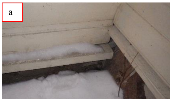
Kuvat 23 a ja b. Rakennuksen itäpuolella perusmuuri on selvästi rakennuksen takaosaa (länsipuolta) matalampi ja ulkopuolinen kosteus (lumi) on paikoin rasittanut alinta hirttä aiheuttaen pintalahoa (b). Alimman hirren lahoa oli havaittavissa myös kohdissa, joissa räystäältä tuleva vesi rasittaa rakennuksen perusmuuria.
