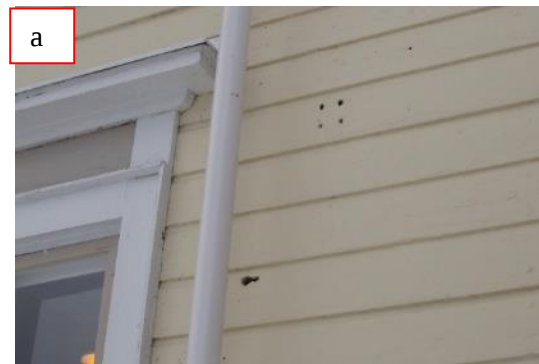
Kuvat 32 a ja b. Ikkunoiden alapuolella, Ikkunapenkin ja ulkoseinän liittymät ovat avoimet (a) ja tilkkeenä on käytetty orgaanista materiaalia, rivettä (b).
