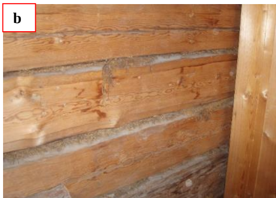
Kuvat 62 a ja b. Kartanon eteläpäädyn ullakkotila. Etualalla, levyseinän takana on WC-tila (a) ja IV-konehuoneen takana on kaksi varastokomeroa. Ullakon lattiapäällysteenä ovat epätiivit levyt ja tilassa on lehtiä ja pahvilaatikoita. Hirsien tilkkeenä on sammal (b). Ullakkotila oli aistinvaraisesti arvioituna kuiva, kattopöydissä on vanhoja vauriojälkiä. Ullakkotilassa on koneellinen poisto.
