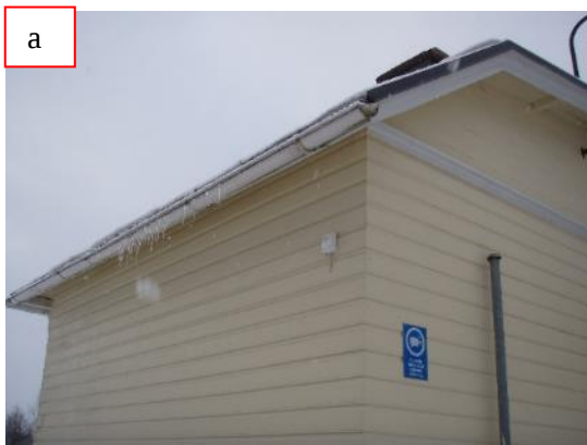
Kuvat 68 a ja b. Vesikaton räystäällä havaittiin jääpuikkoja. Lämmin ilma sulattaa katolla olevaa lumikerrosta puutteellisen lämmöneristyksen takia aiheuttaen lämpövuotoa.
