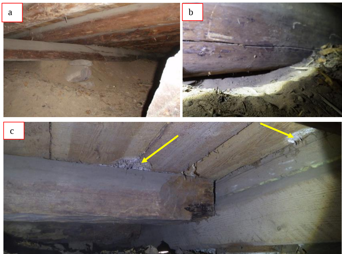
Kuvat 6 a-c. Näkymä kartanon alta eteläsivulle. Primäärihirsi on kiinni kuivassa hiekassa (a) mutta ei ole lahonnut tai vaurioitunut (b). Kohdassa kaivettiin hiekkaa, joka oli kuivaa myös syvemmältä (kaivussyvyys noin 0,5 m). Eteläsivun päässä havaittiin tuuletusaukon läheisyydessä valkoista mikrobikasvustoa (c), joka tunnistettiin Turun yliopistossa katkokääväksi (c, nuolet, liite 1).
