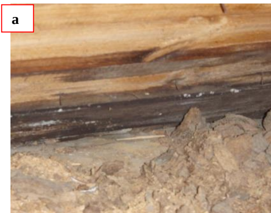
Kuvat 62 a ja b. Kartanon eteläpäädyn ullakkotila. Etualalla, levyseinän takana on WC-tila (a) ja IV-konehuoneen takana on kaksi varastokomeroa. Ullakon lattiapäällysteenä ovat epätiivit levyt ja tilassa on lehtiä ja pahvilaatikoita. Hirsien tilkkeenä on sammal (b). Ullakkotila oli aistinvaraisesti arvioituna kuiva, kattopöydissä on vanhoja vauriojälkiä. Ullakkotilassa on koneellinen poisto.
