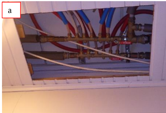
Kuvat 51 a ja b. Talotekniikka on asennettu alaslaskutilaan. Kartanon puolella alaslaskutilassa oli havaittavissa tympeä hajua ja pölyä (b).
