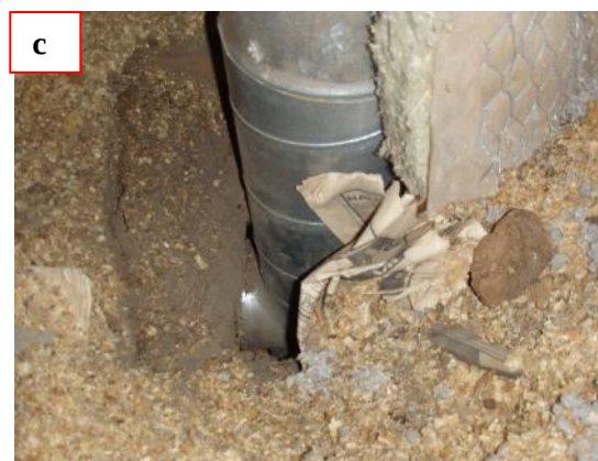
Kuvat 63 a-e. Siiven yläpohjatila. Lämmönjakohuoneen puoleisen päädyn yläpohjan täyttökerros oli lämmin ja koristeikkunan lasin sisäpinta oli sula. Länsipäädyssä puupinnoilla oli vanhoja vauriojälkiä ja puun tummumista vesikaton aluslaudoituksessa päätyräyställä (a), ikkunan lasipinta oli jäässä ja täyttökerros oli viileämpi. Seinän yläosaa on ilmeisesti korjattu (b). Täyttömateriaalina on mm. purua, savea, sammalta ja täytön päällä ei ole laudoitusta. Yläpohjatilassa on ilmanvaihtokanavistoa, joka on eristetty mineraalivillalla (d). Läpiviennit ovat epätiivit (c). Räystäät ovat ummessa, eikä yläpohjatila tuuletetu niiden kautta. Ikkunat olivat heikkokuntoiset.
