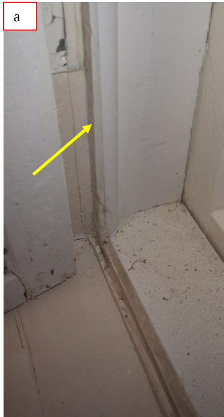
Kuvat 28 a ja b. Kartanon puolella ikkunapuitteiden ja karmen välissä on epätavanomainen kovettunut, joustamaton ja ohut tiiviste (a). Puitteen ja karmen väliin jää paikoin selvä rako (b).
