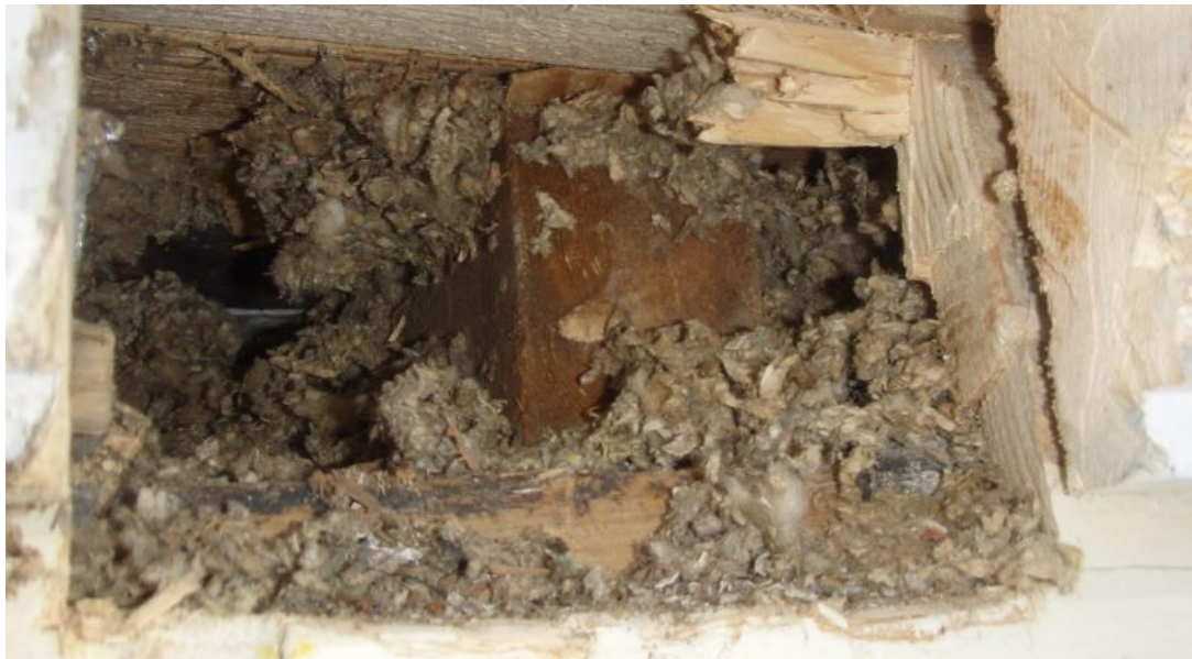
Kuva 44. Rakenneavauskohta RAK45 ikkunan alla. Ulkoseinärakennetta on korjattu, sillä materiaaleina oli selluvilla, polyuretaani ja mineraalivilla. Tuulensuojaa tai hirttä ei havaittu. Kohdassa on koolattu puuseinä, jonka laajuutta ei määritetty.
