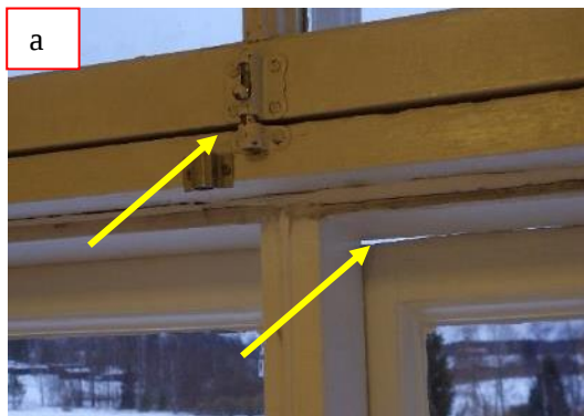
Kuvat 28 a ja b. Kartanon puolella ikkunapuitteiden ja karmen välissä on epätavanomainen kovettunut, joustamaton ja ohut tiiviste (a). Puitteen ja karmen väliin jää paikoin selvä rako (b).
