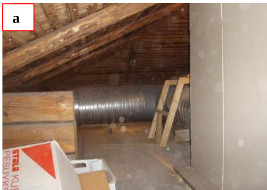
Kuvat 62 a ja b. Kartanon eteläpäädyn ullakkotila. Etualalla, levyseinän takana on WC-tila (a) ja IV-konehuoneen takana on kaksi varastokomeroa. Ullakon lattiapäällysteenä ovat epätiivit levyt ja tilassa on lehtiä ja pahvilaatikoita. Hirsien tilkkeenä on sammal (b). Ullakkotila oli aistinvaraisesti arvioituna kuiva, kattopöydissä on vanhoja vauriojälkiä. Ullakkotilassa on koneellinen poisto.
