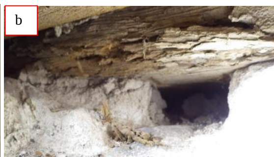
Kuvat 23 a ja b. Rakennuksen itäpuolella perusmuuri on selvästi rakennuksen takaosaa (länsipuolta) matalampi ja ulkopuolinen kosteus (lumi) on paikoin rasittanut alinta hirttä aiheuttaen pintalahoa (b). Alimman hirren lahoa oli havaittavissa myös kohdissa, joissa räystäältä tuleva vesi rasittaa rakennuksen perusmuuria.
