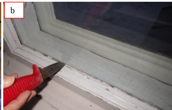
Kuvat 28 a ja b. Kartanon puolella ikkunapuitteiden ja karmen välissä on epätavanomainen kovettunut, joustamaton ja ohut tiiviste (a). Puitteen ja karmen väliin jää paikoin selvä rako (b).
