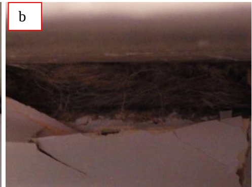
Kuvat 32 a ja b. Ikkunoiden alapuolella, Ikkunapenkin ja ulkoseinän liittymät ovat avoimet (a) ja tilkkeenä on käytetty orgaanista materiaalia, rivettä (b).
