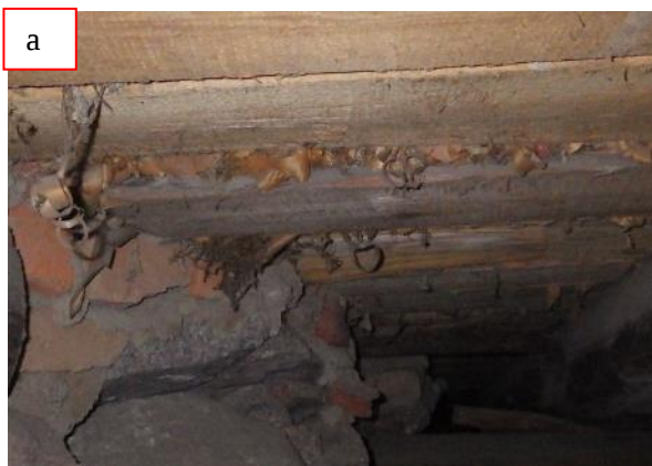
Kuvat 17 a ja b. Alapohjarakenteessa on käytetty pääasiassa sahanpurua, sammalta, sanomalehteä ja puhallusvillaa (a, b, rakenneavaukset). Täyttömateriaali on valunut alapohjan laudoituksen välistä ryömintätilaan.
