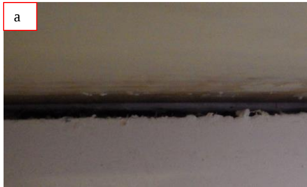
Kuvat 32 a ja b. Ikkunoiden alapuolella, Ikkunapenkin ja ulkoseinän liittymät ovat avoimet (a) ja tilkkeenä on käytetty orgaanista materiaalia, rivettä (b).
