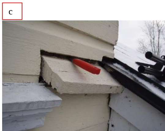
Kuvat 33 a-d. Ulkoseinässä on paikoin avoimia rakoja ja reikiä, jotka mahdollistavat veden pääsyn ulkoseinärakenteeseen.
