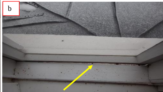
Kuvat 28 a ja b. Kartanon puolella ikkunapuitteiden ja karmen välissä on epätavanomainen kovettunut, joustamaton ja ohut tiiviste (a). Puitteen ja karmen väliin jää paikoin selvä rako (b).
