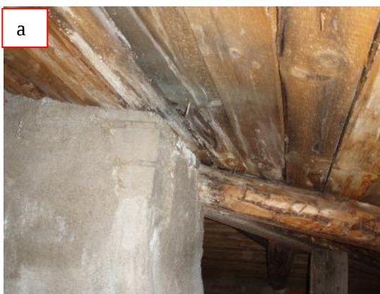
Kuvat 69 a ja b. Siivessä peltikaton alla ei ole aluskatetta. Puun pehmenemistä havaittiin piipun ympärillä (a). Seinän yläosaa on korjattu eteläisivulla ja osin pellin alla on kermi/EPDM-kumi (b). Laudoitus on tummaa, ei kuitenkaan lahonneutta.
