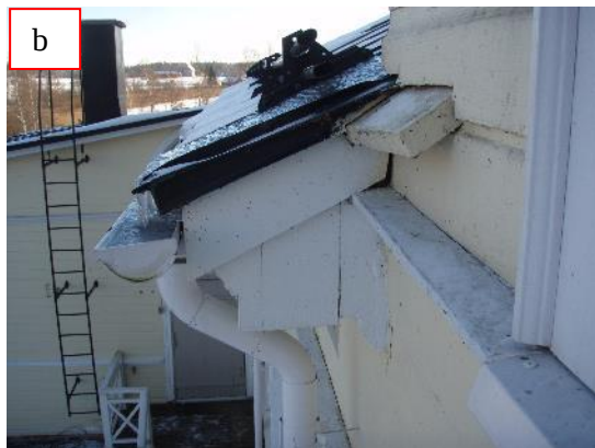
Kuvat 68 a ja b. Vesikaton räystäällä havaittiin jääpuikkoja. Lämmin ilma sulattaa katolla olevaa lumikerrosta puutteellisen lämmöneristyksen takia aiheuttaen lämpövuotoa.
