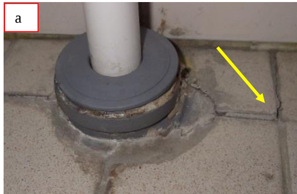
Kuvat 15 a ja b. Alakerran pohjoispäädyn WC-tilassa laatoituksen saumat ovat heikkokuntoiset ja irti.
