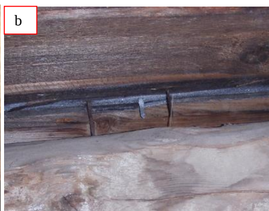
Kuvat 69 a ja b. Siivessä peltikaton alla ei ole aluskatetta. Puun pehmenemistä havaittiin piipun ympärillä (a). Seinän yläosaa on korjattu eteläisivulla ja osin pellin alla on kermi/EPDM-kumi (b). Laudoitus on tummaa, ei kuitenkaan lahonneutta.
