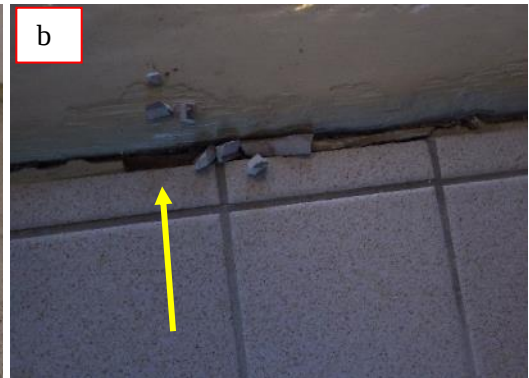
Kuvat 15 a ja b. Alakerran pohjoispäädyn WC-tilassa laatoituksen saumat ovat heikkokuntoiset ja irti.
