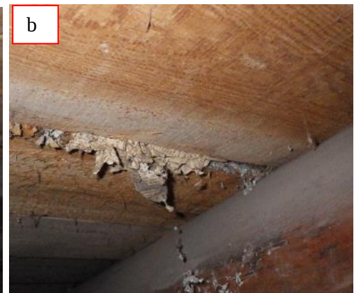
Kuvat 17 a ja b. Alapohjarakenteessa on käytetty pääasiassa sahanpurua, sammalta, sanomalehteä ja puhallusvillaa (a, b, rakenneavaukset). Täyttömateriaali on valunut alapohjan laudoituksen välistä ryömintätilaan.
