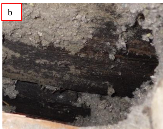
Kuvat 24 a ja b. Siipi ja kartano on rakennettu todennäköisesti eri aikaan. Kuvassa näkyy ilmeisesti kartanon vanha ulkoseinä, jossa tuulensuojana on tuohi ja pinta on mahdollisesti käsitelty kosteutta suojaavasti (a). Ulkoseinästä on tullut myöhemmin väliseinä, kun siipi on rakennettu. Siivessä on käytetty myös hirren pintakäsittelyä hirsien alaosissa, jonka lisäksi hirttä on hiiltynyt väliseinän alaosassa ilmeisesti palon seurauksena (b). Havainnot viittaavat eri rakennusajankohtaan, kun lisäksi huomioidaan, että siivessä käytetyt materiaalit, perusmuuri ja ikkunat ovat erilaiset kuin kartanossa.
