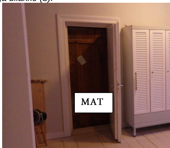
Kuva 5. Materiaalinäyte mikrobianalysiin (MAT) otettiin ullakon puoleisesta maa-laamattomasta puuovesta.
