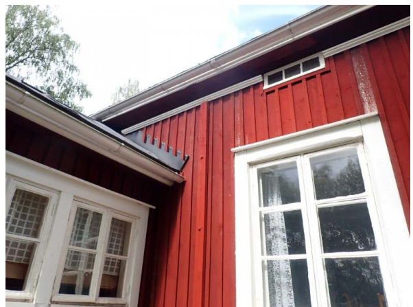
21. Ulkoseinää on kunnostettu
