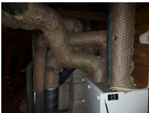
55. Ilmanvaihtokanavaa ullakolla (eristetty asiallisesti).
