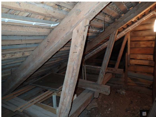
38. Kattokannattimissa ei havaittu vaurioita
