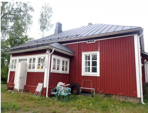
20. Julkisivua etupihan puolelta
