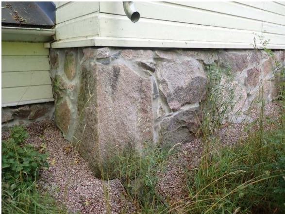
24. Sokkelit ovat pääosin kunnossa
