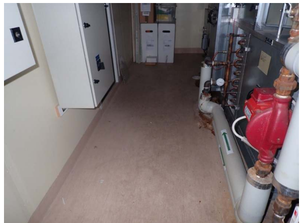
65. Teknisen tilan lattiapinnoitetta
