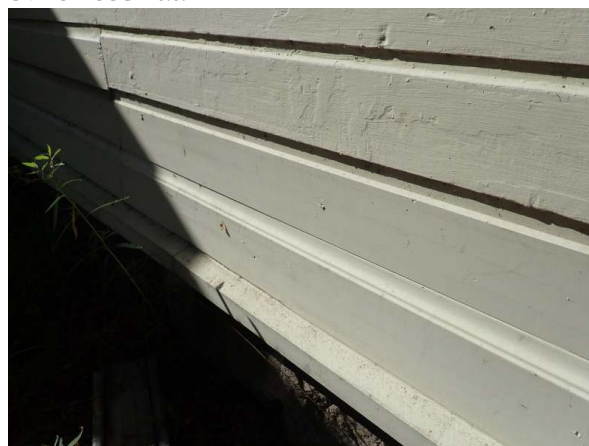
39. Ulkoseinän alaosien lautaverhousta on uusittu jossain vaiheessa.
