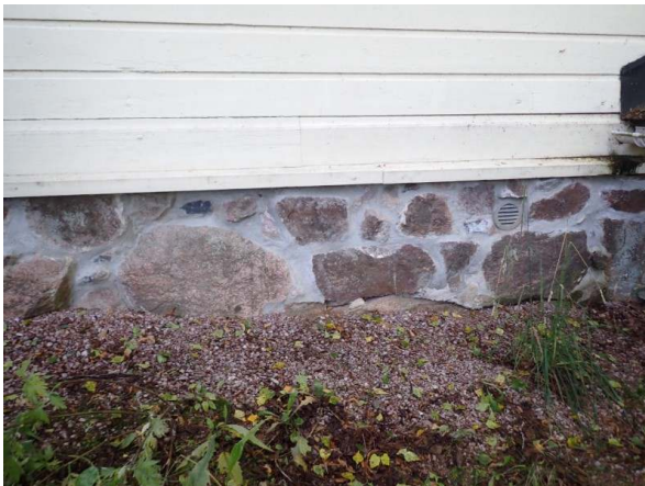
22. Sokkelikivet on väleistä saumattu laasteilla
