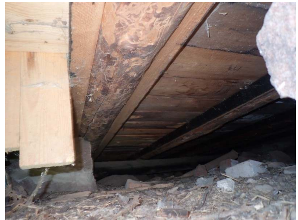
27. Alapohjarakenteissa ei todettu näkyviä vaurioita pistokokein tarkasteltuna
