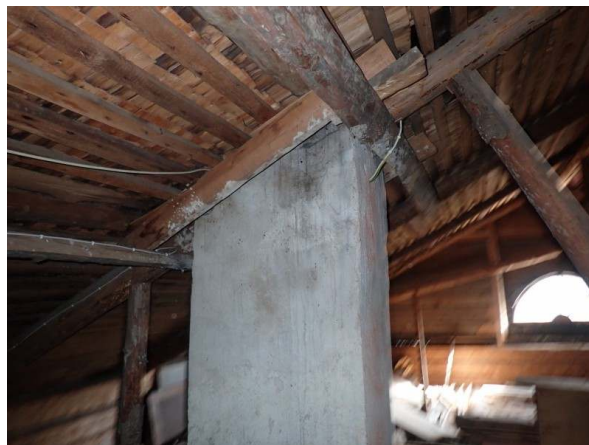
57. Yläpohjatilassa oleva hormi
