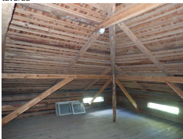
58. Kattorakenteissa ei havaittu vaurioita
