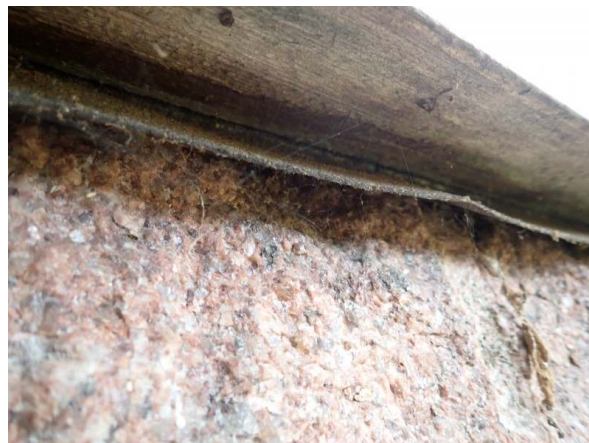
35. Ulkoseinän alajuoksun alapuolelle on lisätty kapillaarikatko
