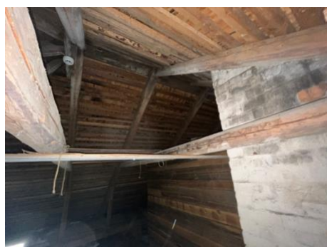
Pärekatossa havaittiin vanhoja vesijälkiä. Ullakolla oli runsaasti hiirien jälkiä ja jätöksiä
