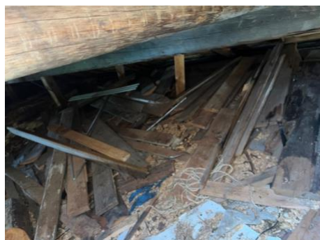
Siiven yläpohjan tuulettuvasta tilasta. Räystäään tuuletusväliä ei havaittu.
