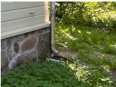
Takapihan kattovesien ohjausta.
