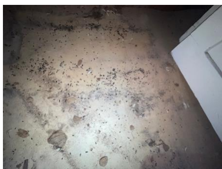
Pärekatossa havaittiin vanhoja vesijälkiä. Ullakolla oli runsaasti hiirien jälkiä ja jätöksiä
