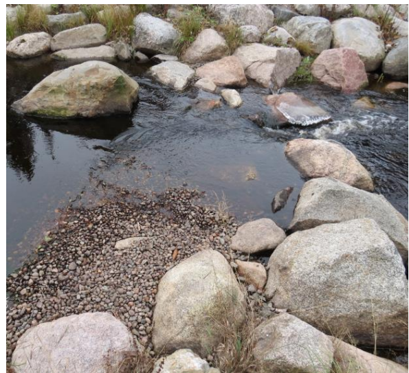
Kuva 12-3. Puinen pohjakynnykset ja virtaa ohjaavat suistepuut (Ahoja & Havumäki, 2008), ja kivistä tehty pohjakynnykset (Vanajavesikeskus, 2024).
