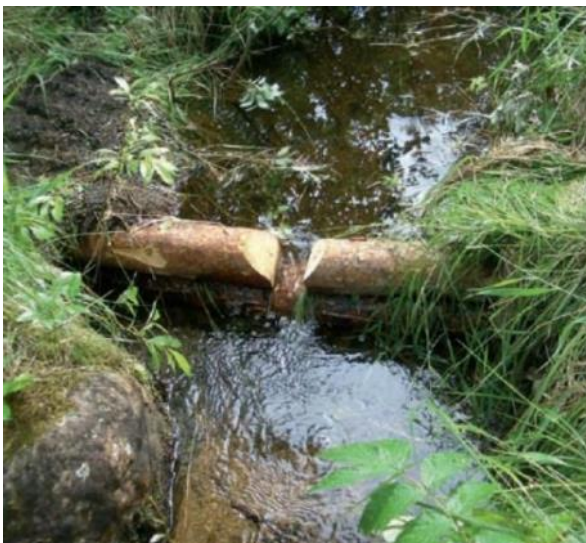
Kuva 12-3. Puinen pohjakynnykset ja virtaa ohjaavat suistepuut (Ahoja & Havumäki, 2008), ja kivistä tehty pohjakynnykset (Vanajavesikeskus, 2024).
