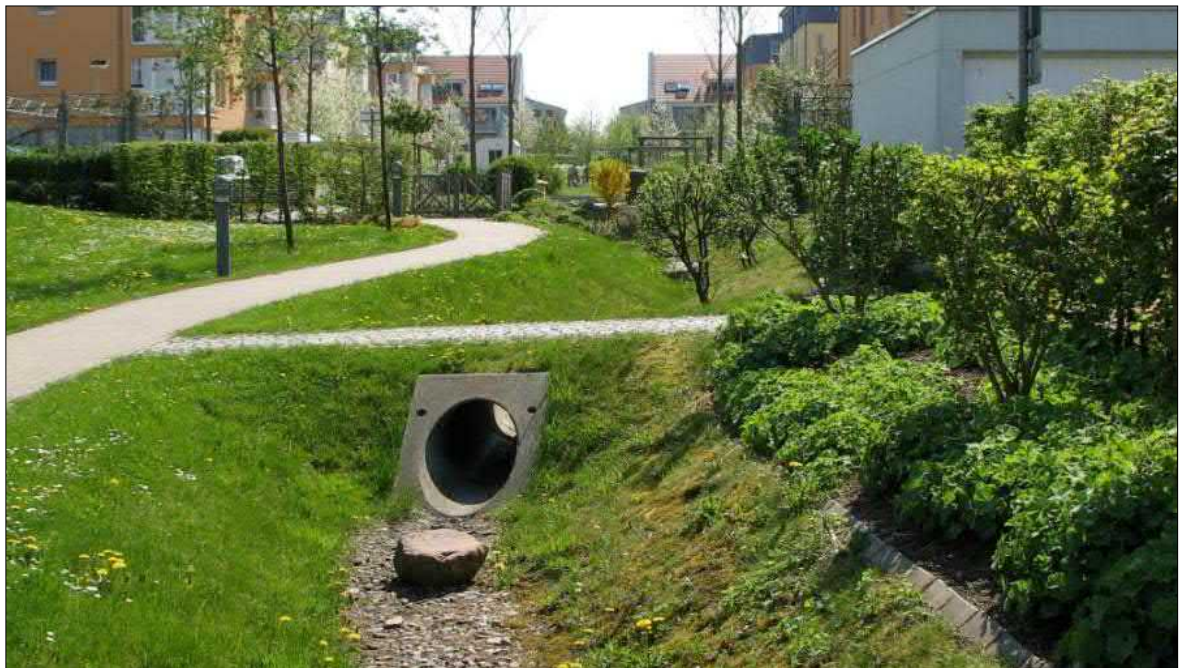
Kuva 23. Avo-oja yleisellä puistoalueella johtaa asuinalueen hulevedet. 9
