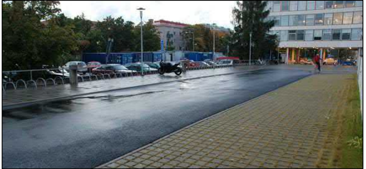
Kuva 15. Vettä läpäisevä päällyste Tampereen Sampolassa Error! Bookmark not defined. . Kuvasta nähdään että vettä läpäisevä päällyste on sadetapahtuman jälkeen silmämääräisesti kuivempi kuin perinteinen asfalttipinta. 9
