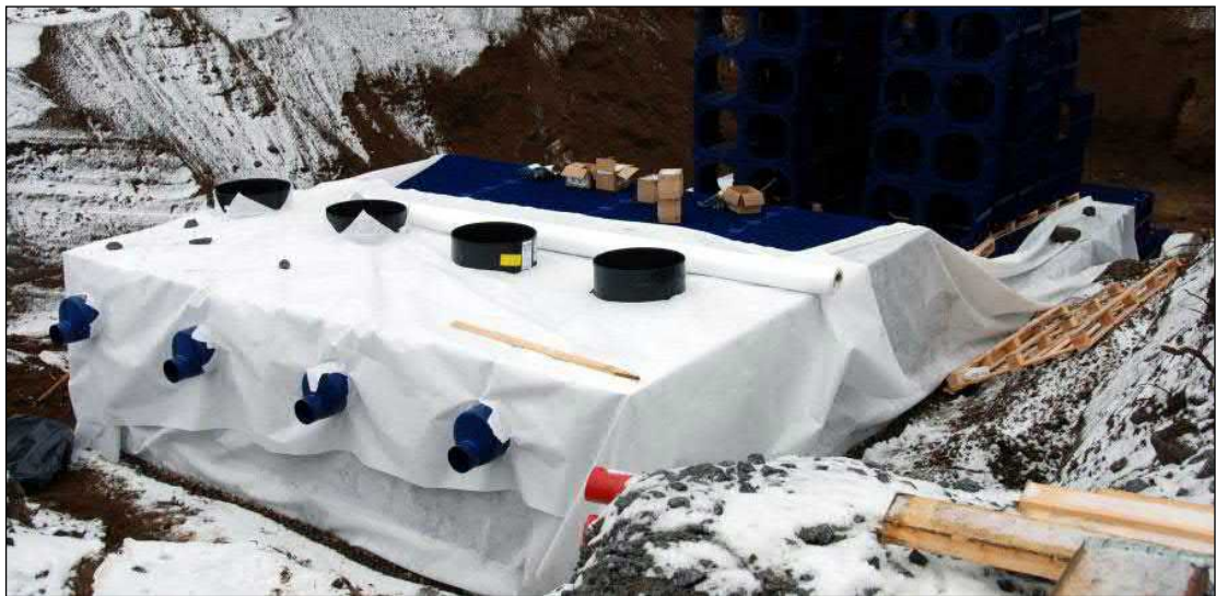
Kuva 20. Maanalaisen 300 m 3 kennoston rakentamista Tampereella. Error! Bookmark not defined.
