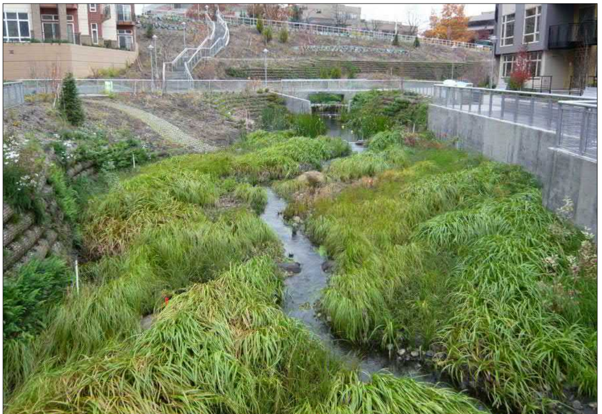
Kuva 25. Esimerkki puron johtamisesta tiiviin rakennetun alueen sisällä. Thornton Creek, Yhdysvallat. 9
